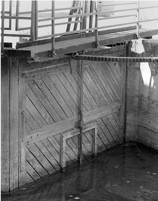
Porte amont droite : tige de manoeuvre et guide de la vantelle.
