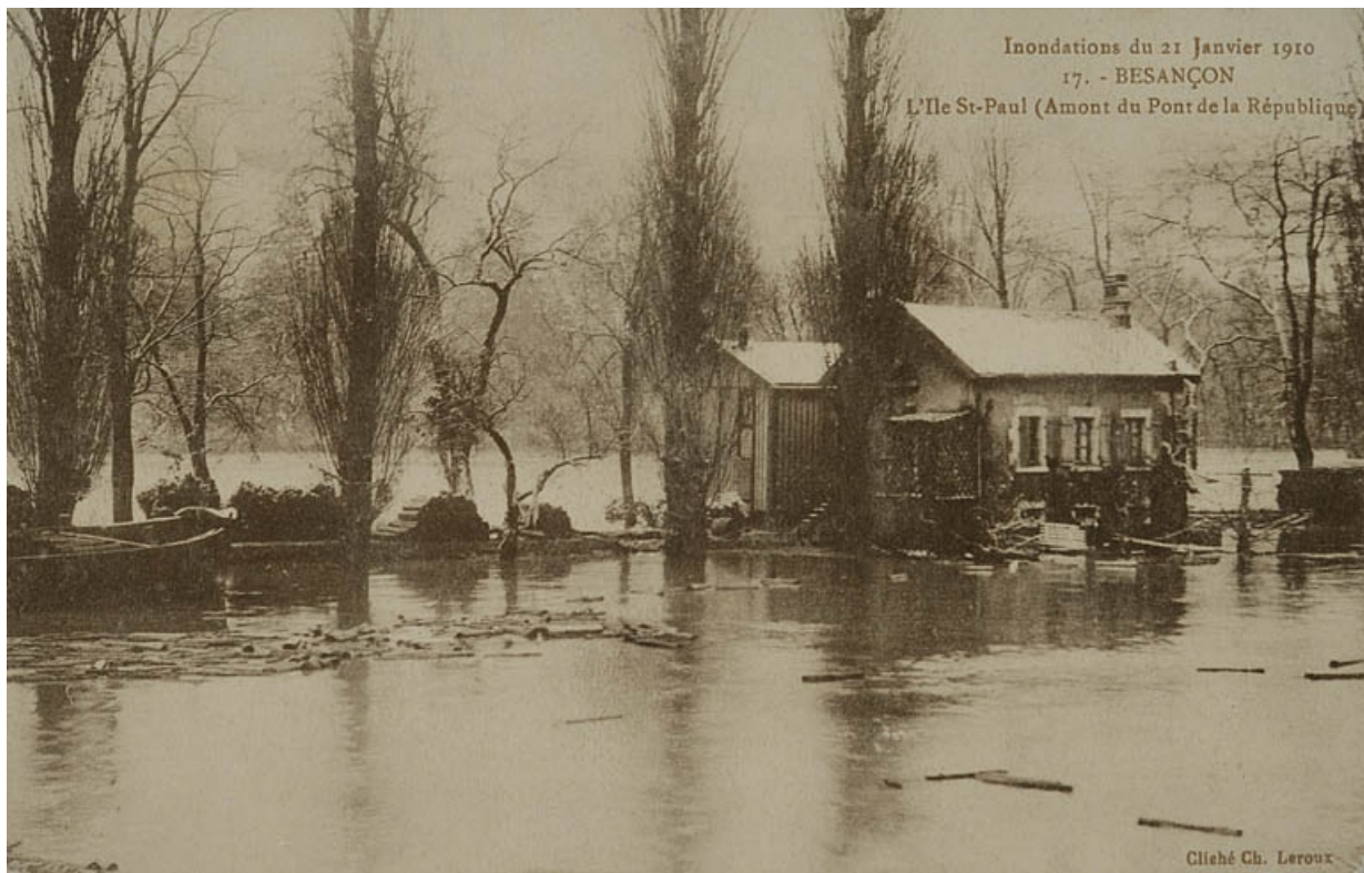
Inondations du 21 janvier 1910. 17. - Besançon. L'Île St-Paul (Amont du Pont de la République).
