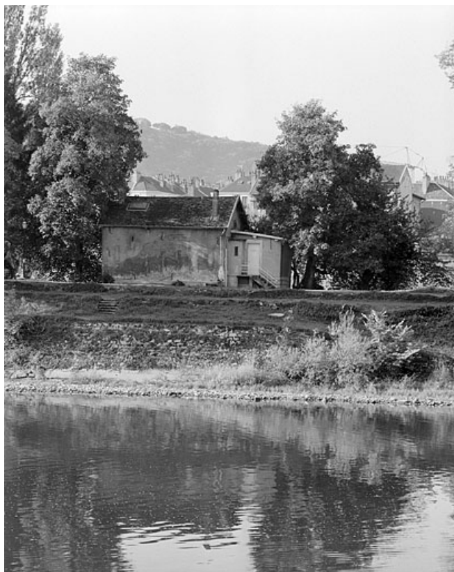
Façade antérieure en 2003, avant restauration.
