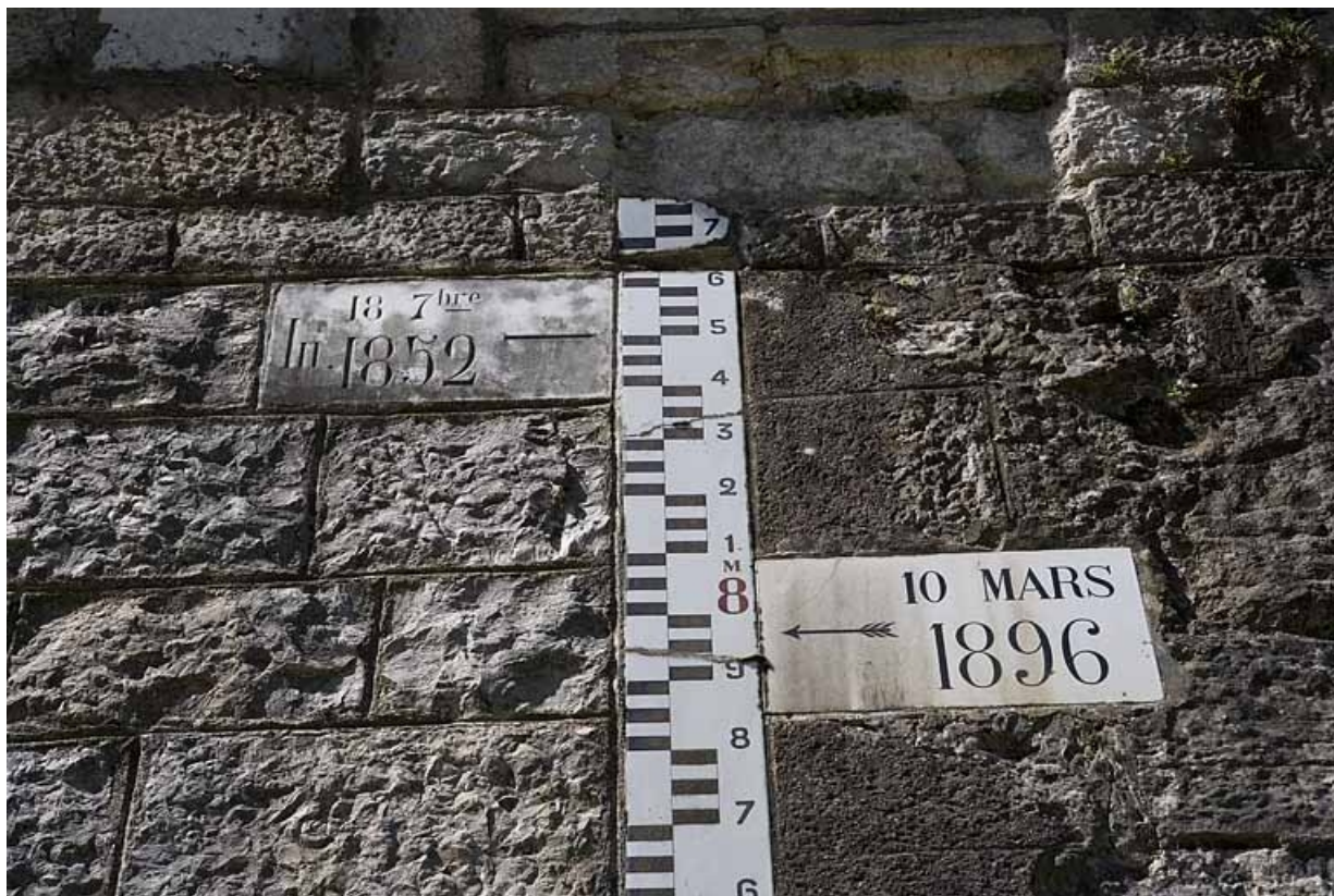
Partie supérieure de l'échelle limnimétrique, indiquant le niveau des crues de 1852 et 1896. Trois crues sont signalées : 10 mars 1896 (7,96 m), 18 septembre 1852 (8,50 m) et 21 janvier 1910 (9,57 m). La plaque de cette dernière manque. 25, Besançon, 4 pont de la République, lieudit : îlot Moulin Saint-Paul
