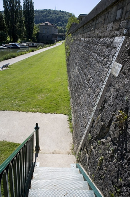
Le chemin de halage et la courtine, depuis le pont de la République. A droite, échelle limnimétrique (ou hydrométrique). 25, Besançon, 4 pont de la République, lieudit : îlot Moulin Saint-Paul
