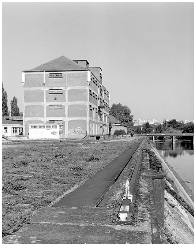
Entrepôt et quai, depuis l'amont (vue rapprochée)
