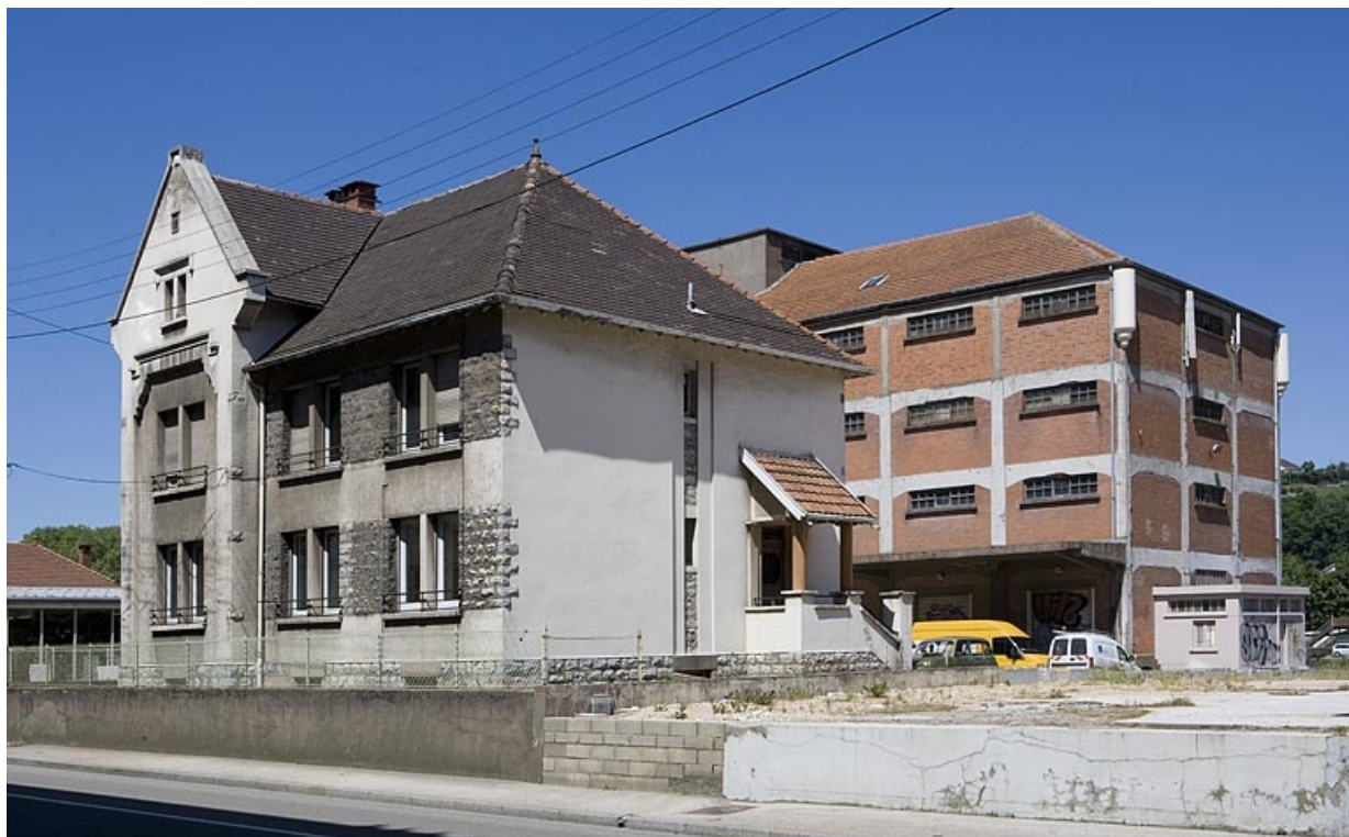
Bureau : façade antérieure de trois quarts droite.
