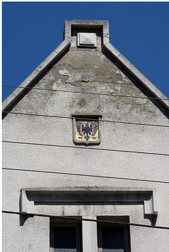
Bureau : armoiries dans le pignon de la façade antérieure.
