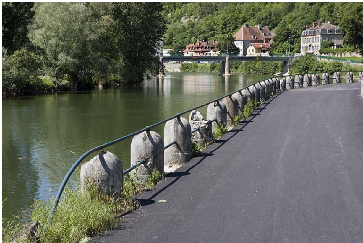
Evitement de la porte Malpas : garde-corps avec bornes en pierre. 25, Besançon
