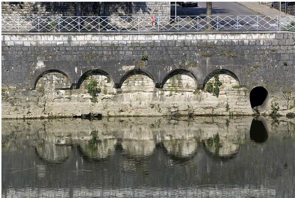
Arches dans le quai bordant le Doubs rive droite, en aval du pont Canot. 25, Besançon
