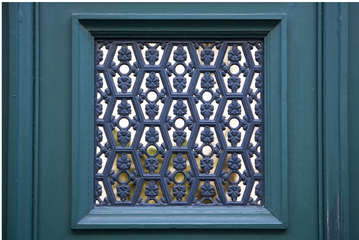
Portail d'entrée : détail du décor en fonte d'un vantail de la porte.
