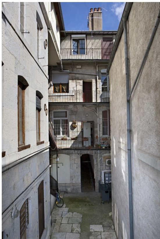
Vue d'ensemble de la façade postérieure du logis principal depuis le fond de la cour. 25, Besançon, 90 rue des Granges, lieudit : îlot Forum
