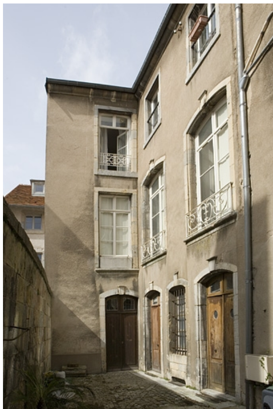
Vue d'ensemble de la cour secondaire donnant sur la rue de la Bibliothèque. 25, Besançon, 88 rue des Granges, lieudit : îlot Forum
