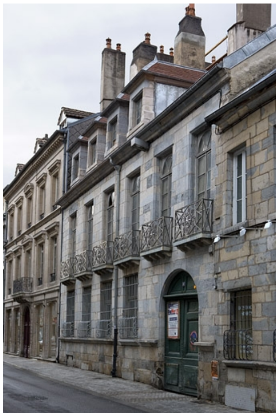
Vue d'ensemble depuis la rue de trois quarts droit. 25, Besançon, 86 rue des Granges, lieudit : îlot Forum
