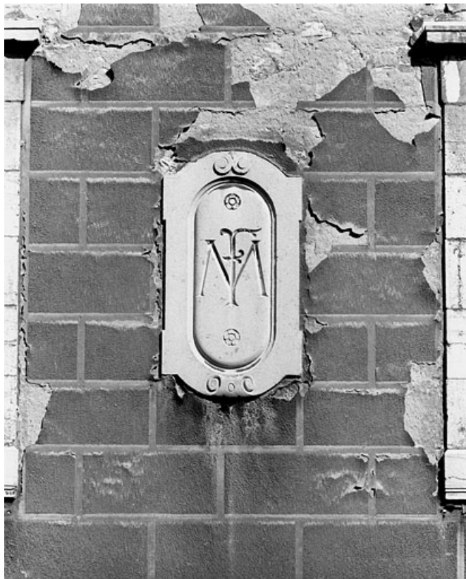
Logis secondaire : façade antérieure, détail du médaillon droit. 25, Besançon, 86 rue des Granges, lieudit : îlot Forum
