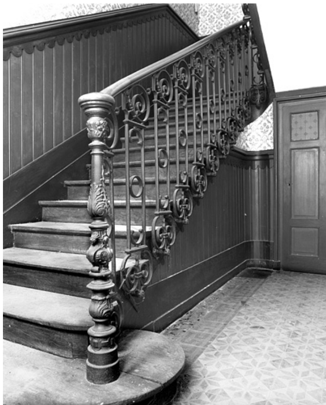
Logis secondaire droit : intérieur, détail de l'escalier.
