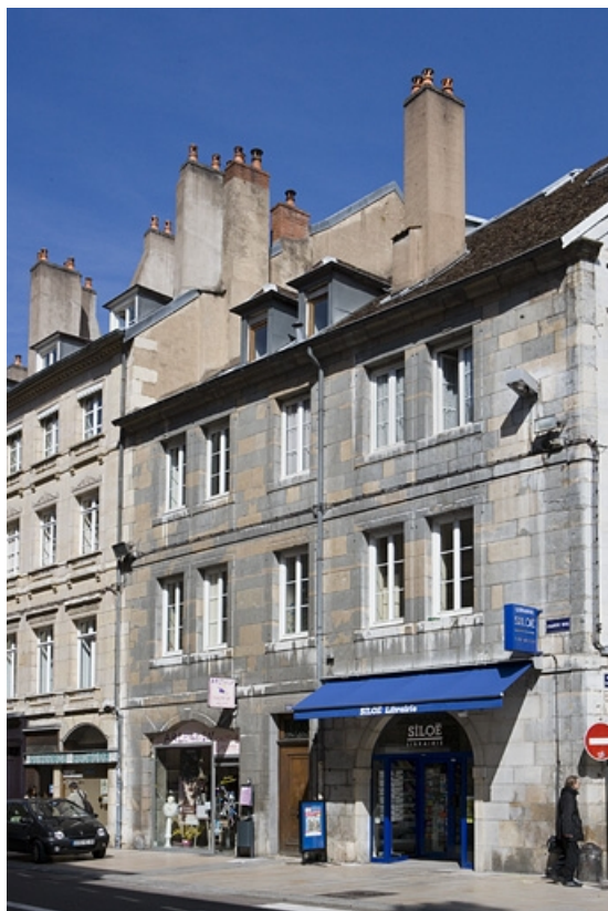
Vue d'ensemble de la façade principale du logis sur rue de trois quarts droit. 25, Besançon Grande Rue 119, lieudit : îlot Forum
