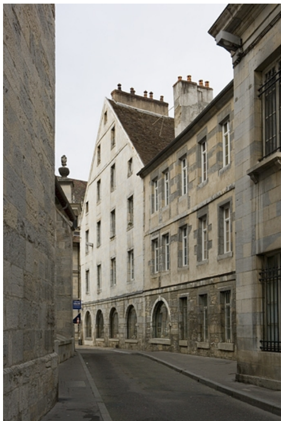
Détail de la façade latérale du logis principal et du logis secondaire depuis la rue de la Bibliothèque. 25, Besançon Grande Rue 119, lieudit : îlot Forum
