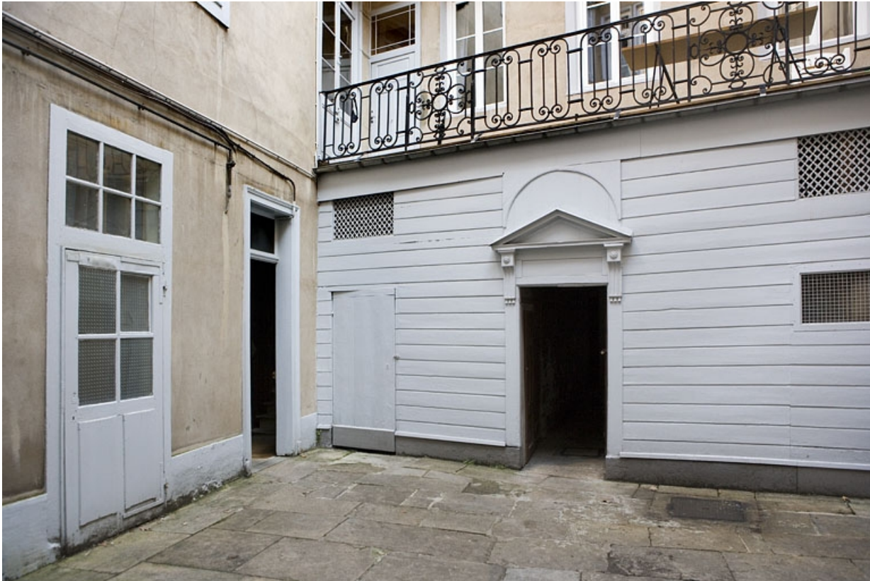
Vue du rez-de-chaussée des bâtiments au fond de la première cour : de trois quarts gauche. 25, Besançon Grande Rue 119, lieudit : îlot Forum
