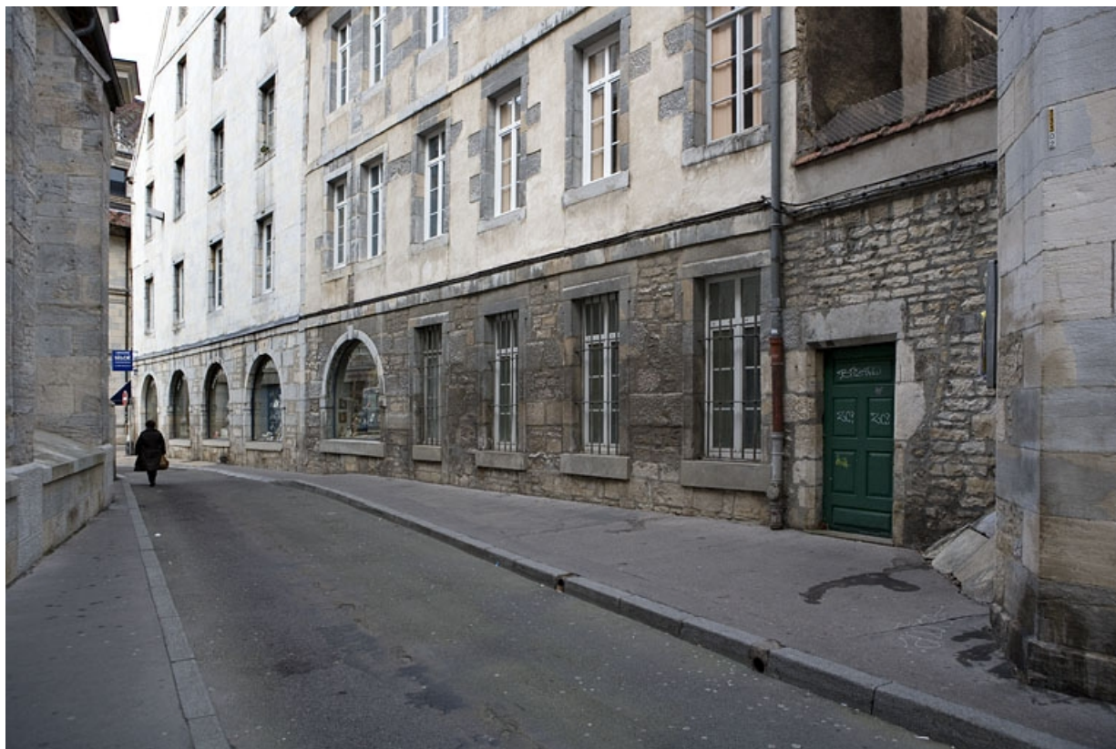
Détail des rez-de-chaussée de la façade latérale du logis principal et du logis secondaire depuis la rue de la Bibliothèque. 25, Besançon Grande Rue 119, lieudit : îlot Forum
