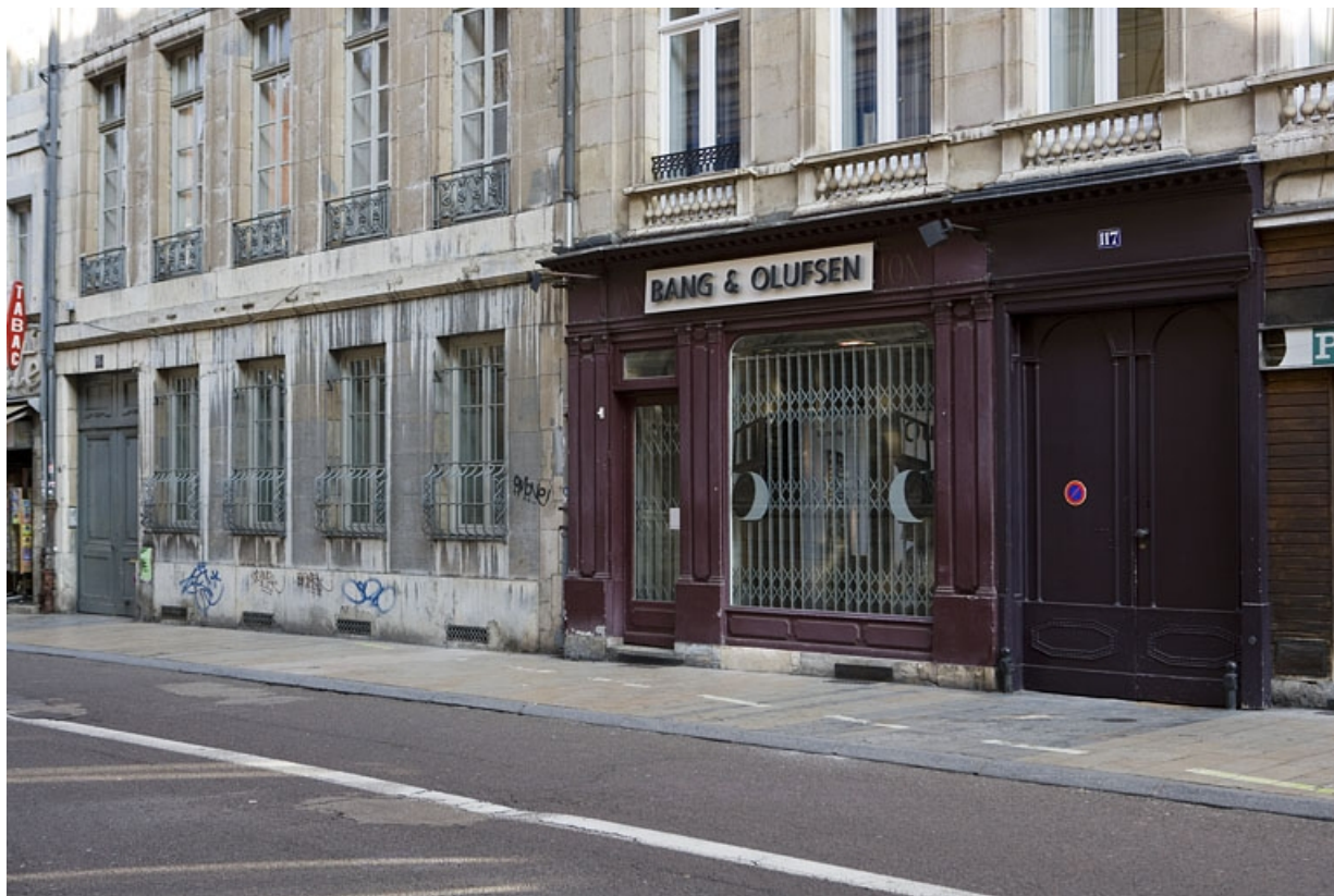
Logis principal, façade sur rue : détail de la devanture du magasin de trois quarts droit.
