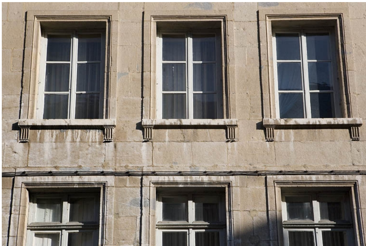
Logis principal sur rue : détail des fenêtres du deuxième étage.
