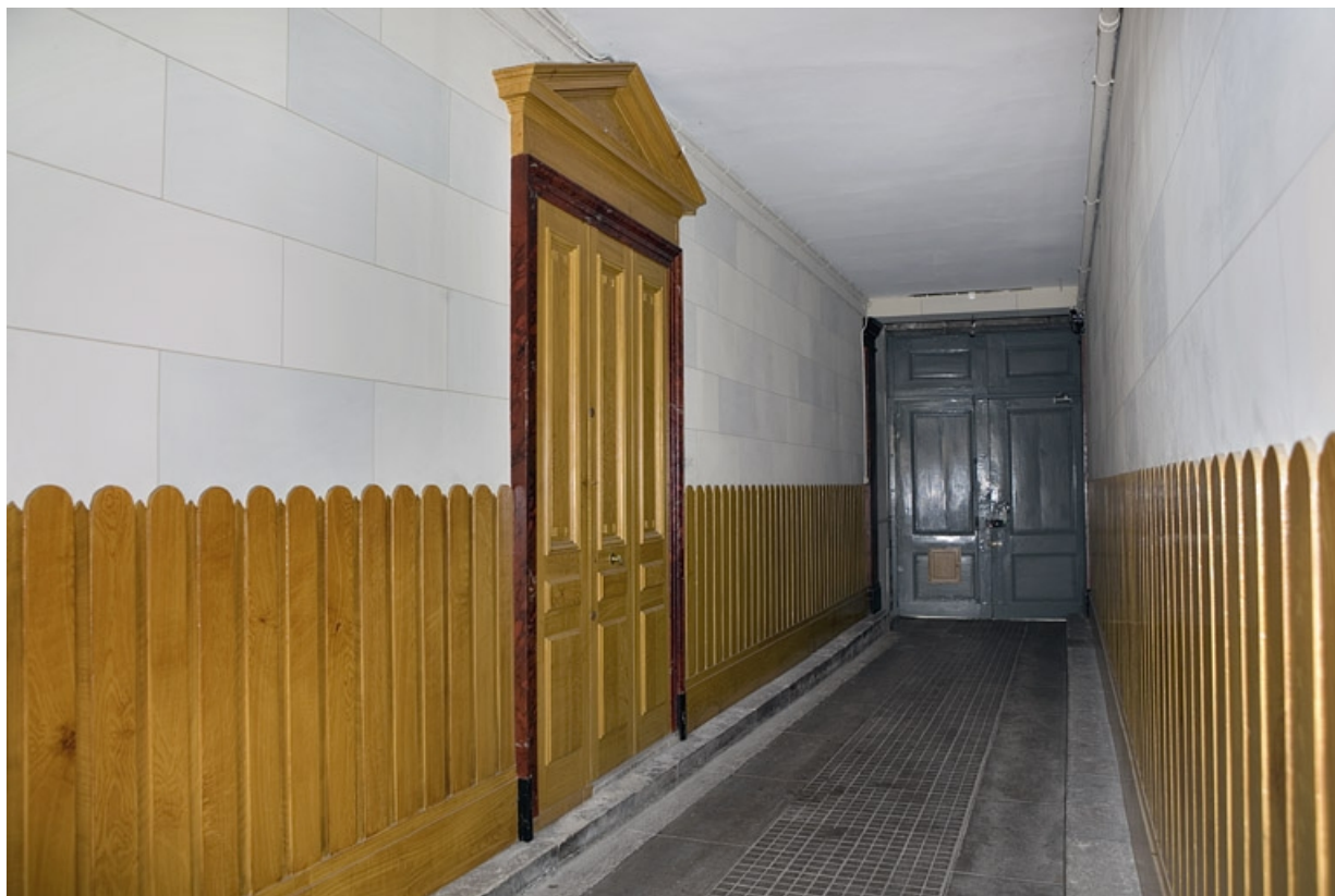
Détail du passage cocher depuis l'entrée de la cour.
