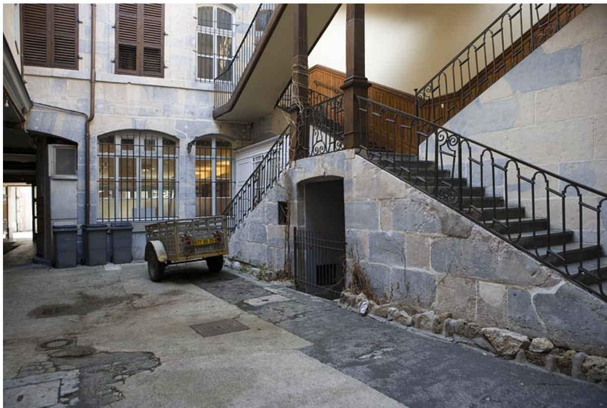
Détail de la première volée de l'escalier à cage ouverte depuis le fond de la première cour.
