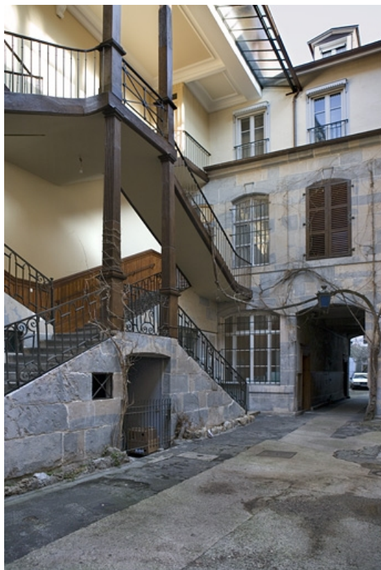
Détail de l'escalier à cage ouverte et de la façade antérieure du premier logis secondaire.
