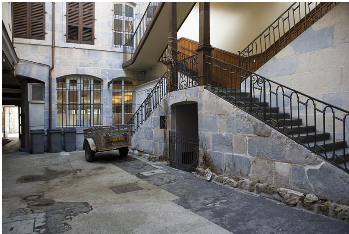
Détail de la première volée de l'escalier à cage ouverte depuis le fond de la première cour.
