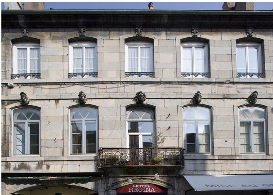
Vue d'ensemble de la façade sur rue à partir du premier étage : de face.
