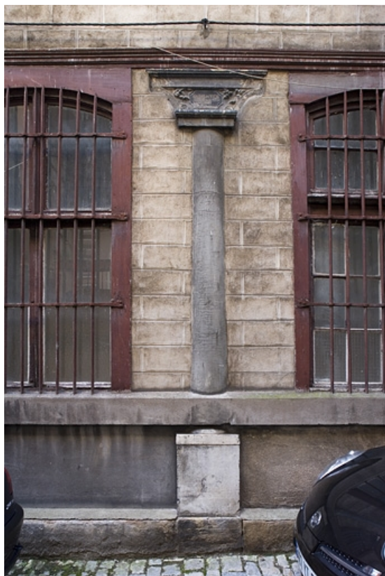
Détail d'une colonne du portique à droite de la deuxième cour.
