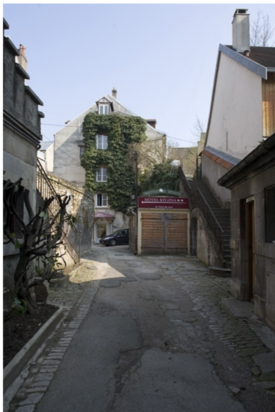
Vue d'ensemble du logis secondaire au fond de la deuxième cour.
