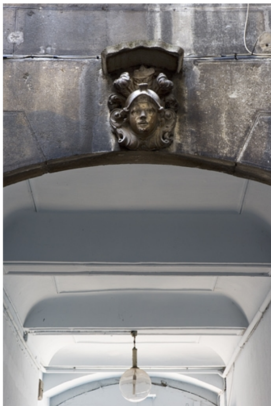
Première cour : détail du plafond du passage cocher avec une figure casquée sur la clé d'un arc. 25, Besançon Grande Rue 91, lieudit : îlot Forum
