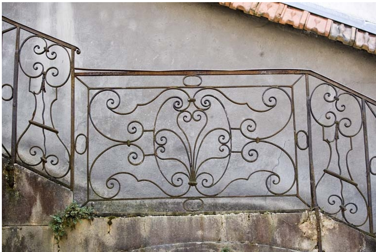
Détail de la rampe en fer forgé de l'escalier isolé dans la deuxième cour.
