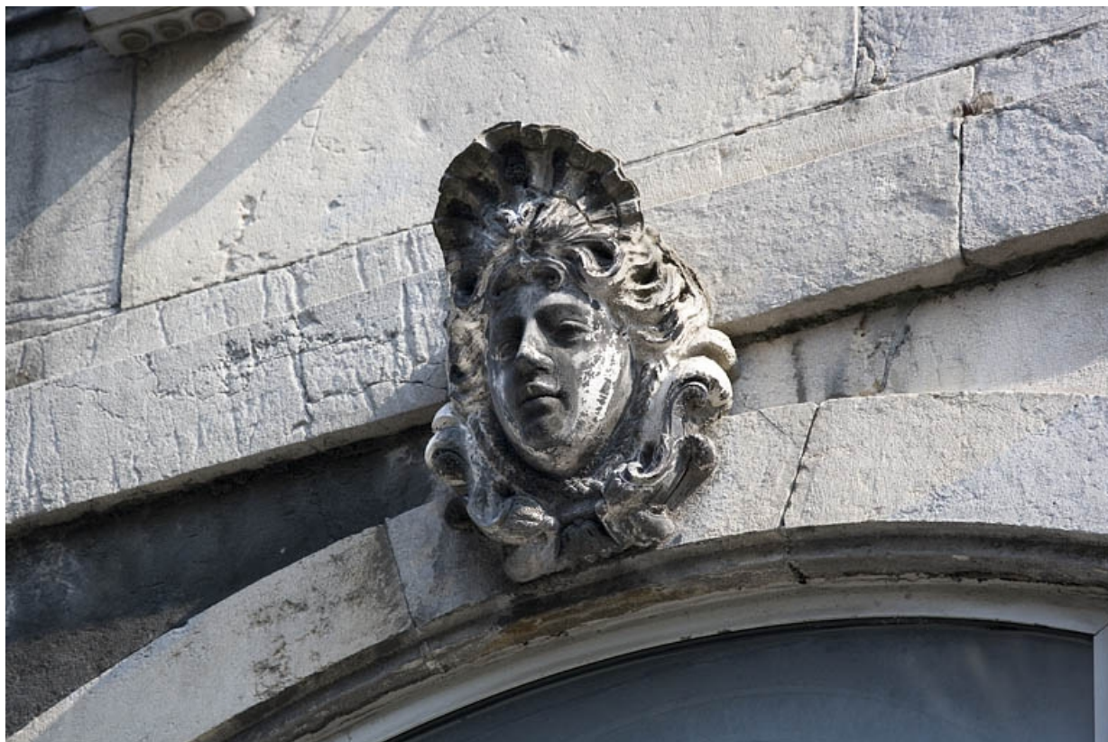
Détail de la clé d'une fenêtre au premier étage sur rue : figure coiffée d'une coquille.
