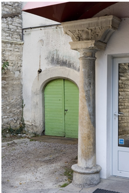
Détail de la colonne à gauche : entrée du logis secondaire au fond de la deuxième cour. 25, Besançon Grande Rue 91, lieudit : îlot Forum
