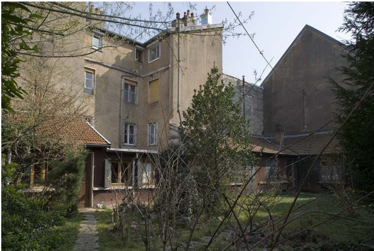
Vue d'ensemble de l'actuel institut de beauté sur la terrasse gallo-romaine.
