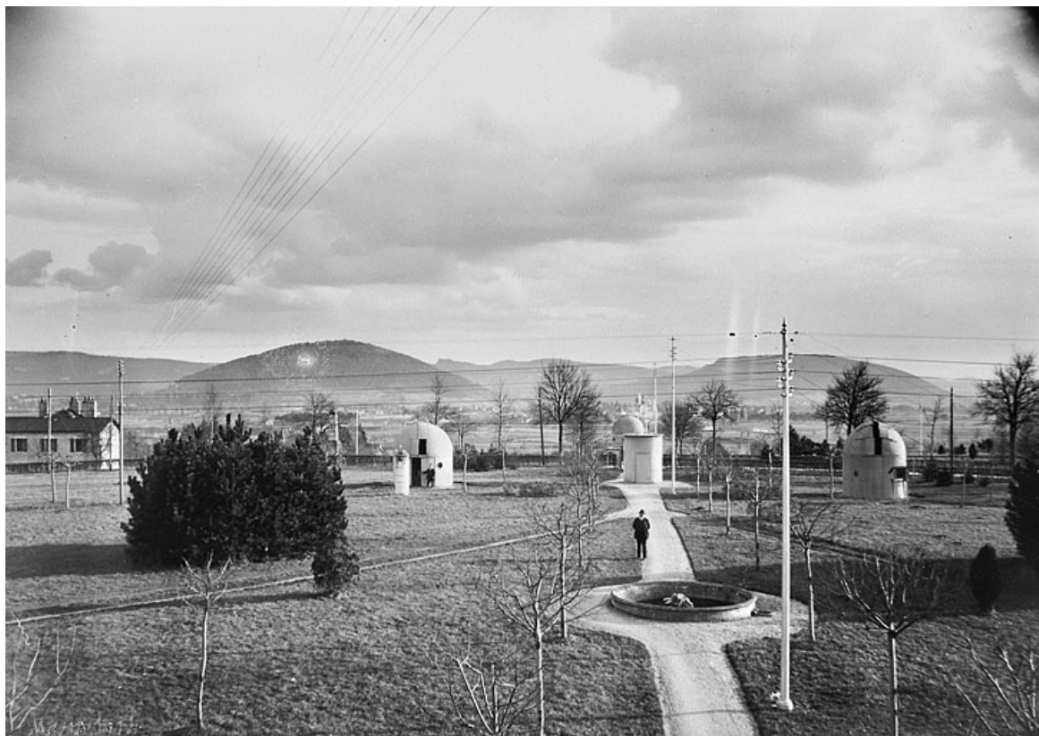
[Vue d'ensemble des coupoles et du bassin, depuis le nord], 1914.
