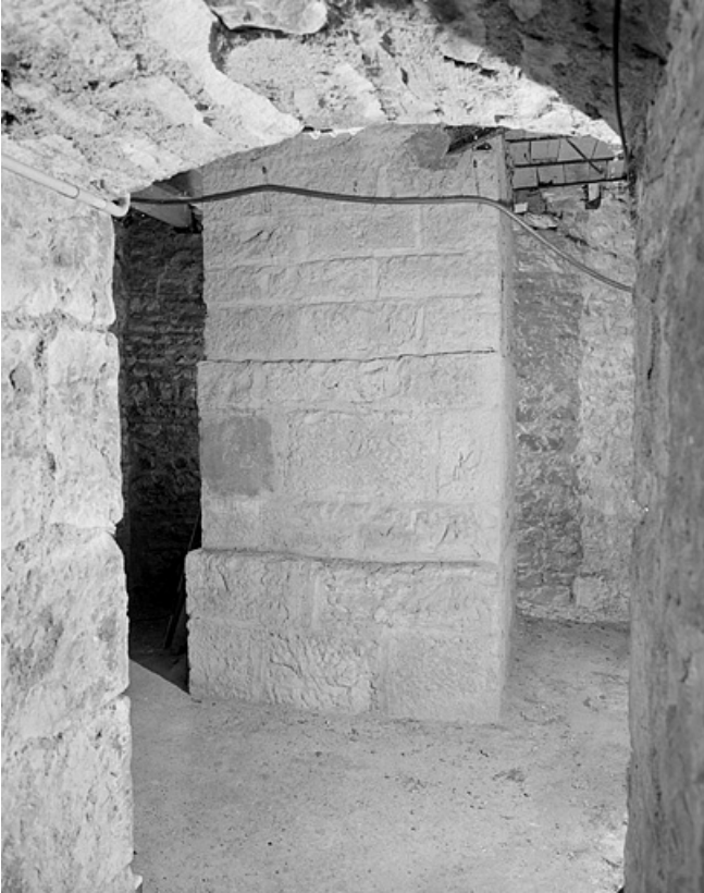
Sous-sol de la tour de l'équatorial coudé : vue d'ensemble du pilier de la lunette.
