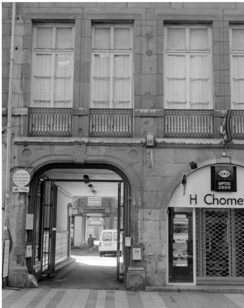
Façade sur rue, détail de l'entrée cochère.
