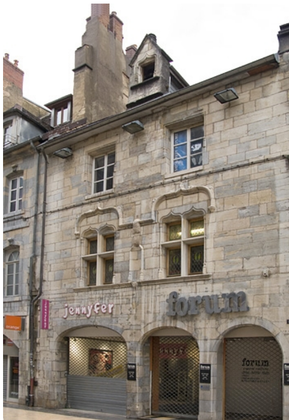
Façade antérieure du 15 Grande Rue : de trois quarts droit.
