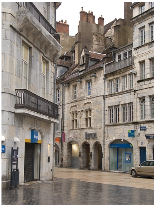
Façade antérieure du 15 Grande Rue : vue éloignée de trois quarts droit. 25, Besançon Grande Rue 13, 15, lieudit : îlot Chevanney
