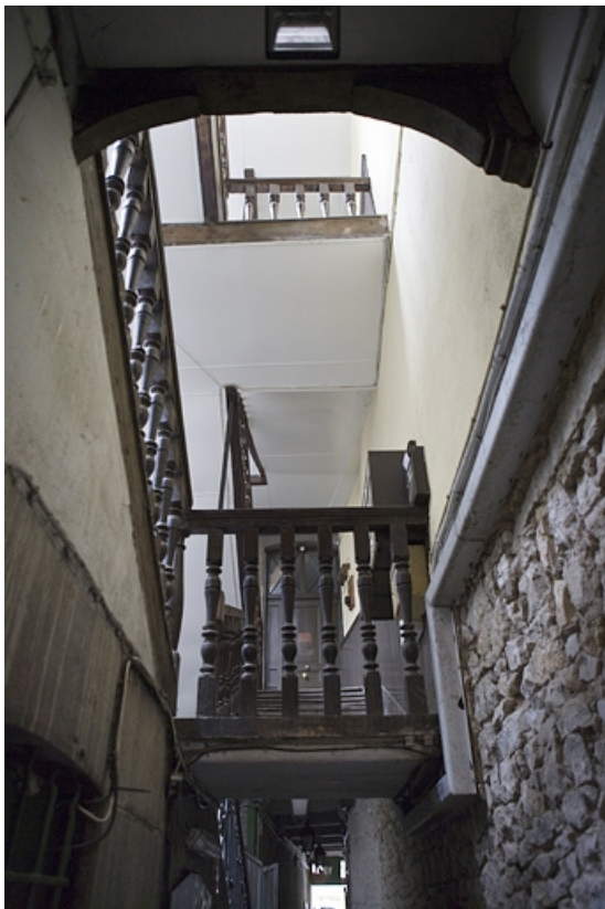
Détail de l'escalier à cage ouverte dans la première cour : 13 Grande Rue. 25, Besançon Grande Rue 13, 15, lieudit : îlot Chevanney
