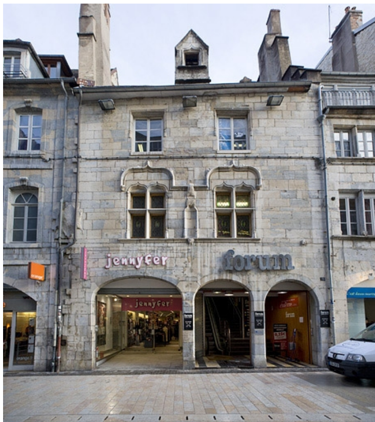
Façade antérieure du 15 Grande Rue : de face.
