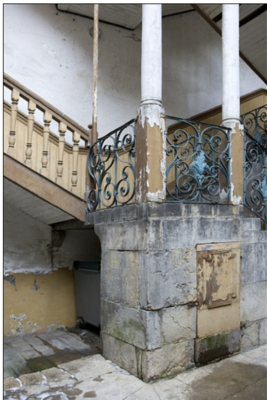
Détail du soubassement de l'escalier à cage ouverte et de l'entrée de cave.
