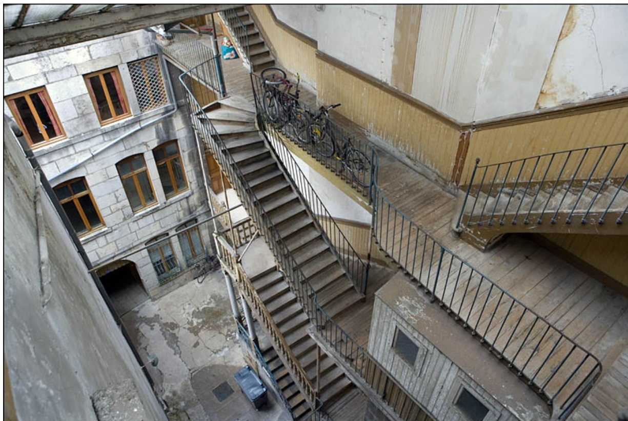
Vue d'ensemble de la façade antérieure du premier logis secondaire et de l'escalier à cage ouverte. 25, Besançon Grande Rue 17, lieudit : îlot Chevanney
