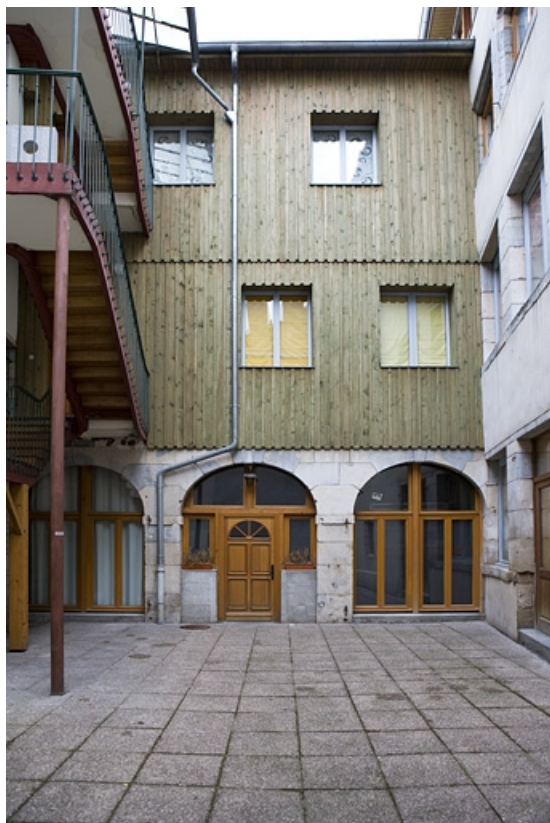
Deuxième cour : aile droite du logis secondaire avec d'anciennes dépendances artisanales au rez-de-chaussée. 25, Besançon Grande Rue 17, lieudit : îlot Chevanney
