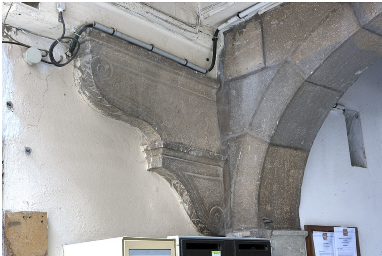
Détail d'une console soutenant la coursière.
