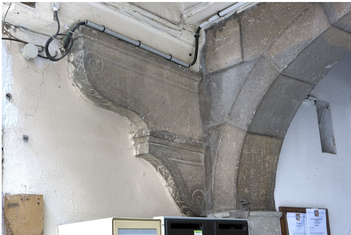
Détail d'une console soutenant la coursière.
