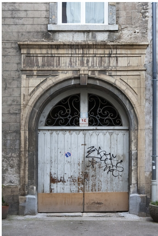
Détail de l'entrée du passage cocher donnant sur l'impasse : vue rapprochée. 25, Besançon, 16 place de la Révolution, lieudit : îlot Chevanney
