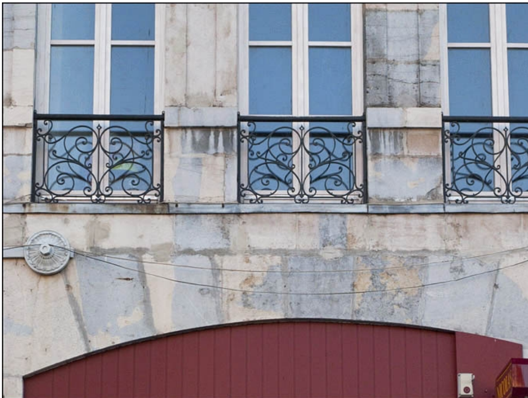
Façade antérieure : détail des garde-corps des fenêtres du premier étage.
