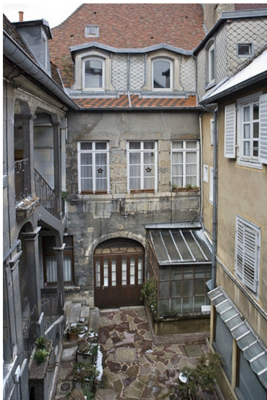
Façade postérieure du logis principal depuis les communs, de face. 25, Besançon, 12 place de la Révolution, lieudit : îlot Chevanney
