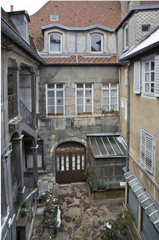
Façade postérieure du logis principal depuis les communs, de face. 25, Besançon, 12 place de la Révolution, lieudit : îlot Chevanney
