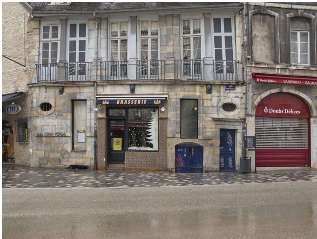
Détail de la façade antérieure du logis secondaire, rue des Boucheries. 25, Besançon Grande Rue 3, lieudit : îlot Chevanney
