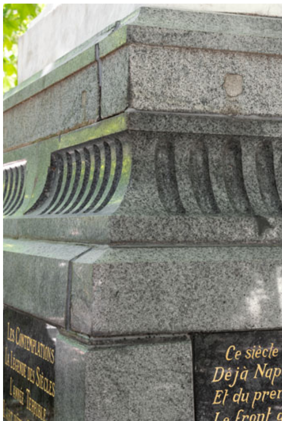
Monument dédié à Victor Hugo : détail du socle en porphyre vert fourni par la graniterie du Pont de Miellin. 25, Besançon rue de la Préfecture, lieudit : îlot Granvelle
