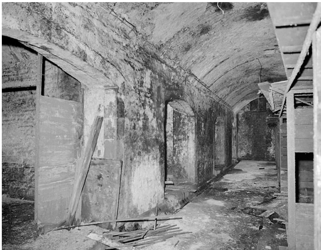
Rez-de-chaussée, sous la grande salle, pièce transversale à l'est.
