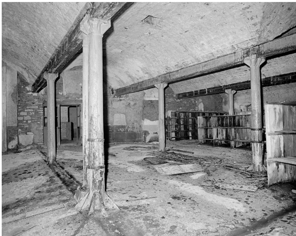
Premier étage, grande salle, côté ouest. 25, Montbéliard, 12 rue des Huisselets
