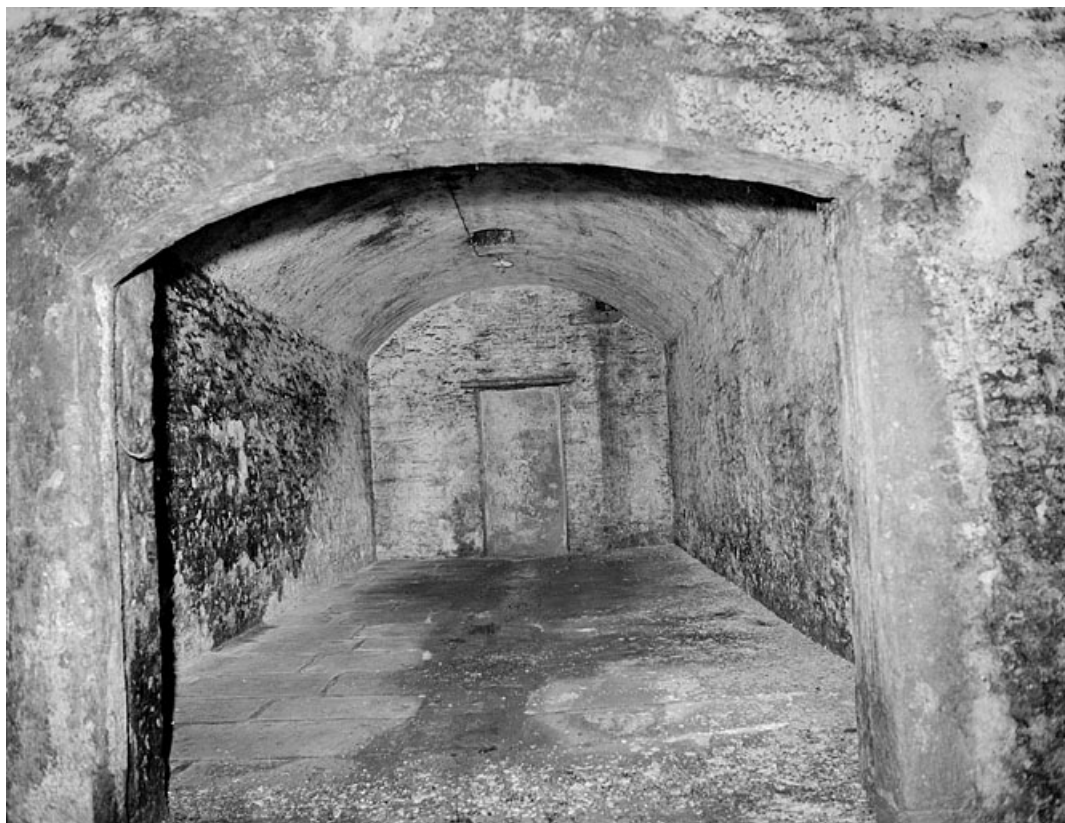
Rez-de-chaussée, sous la grande salle, une des 4 pièces parallèles.
