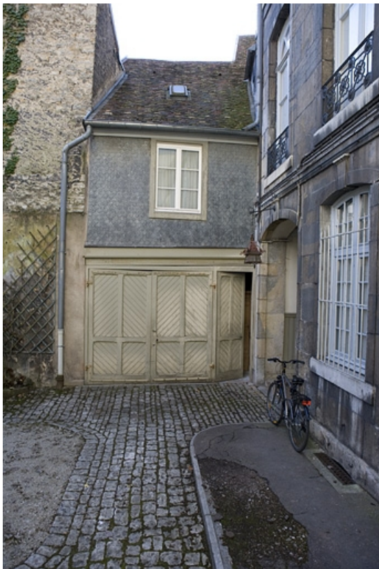
Détail d'une remise à droite de la cour.
