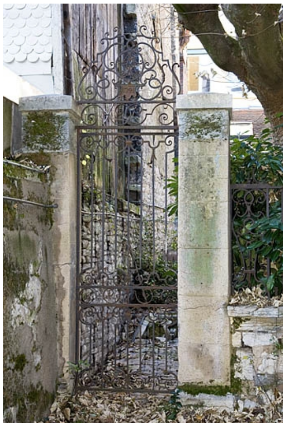
Vue d'ensemble de porte en fer forgé conduisant au jardin.
