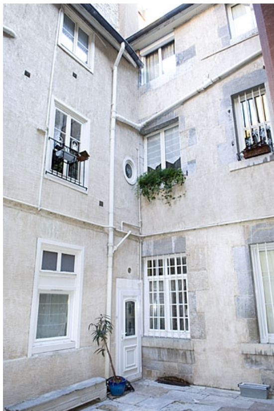
Vue d'ensemble de la façade postérieure du logis principal et de l'aile sur cour. 25, Besançon, 16 rue Ronchaux, lieudit : îlot Granvelle
