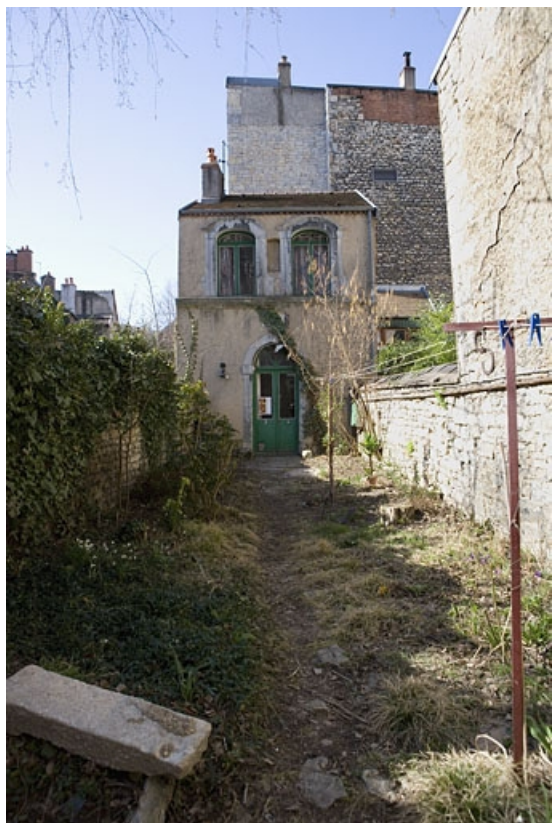
Vue d'ensemble de la fabrique de jardin au fond de la parcelle.
