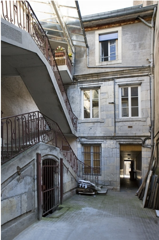
Vue d'ensemble de la façade postérieure du logis principal et de l'escalier à cage ouverte. 25, Besançon Grande Rue 122, lieudit : îlot Granvelle
