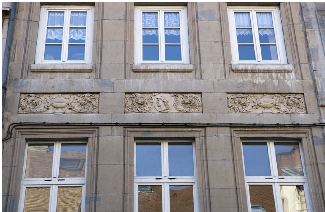
Détail du décor des tables rentrantes entre le premier et le deuxième étage.
