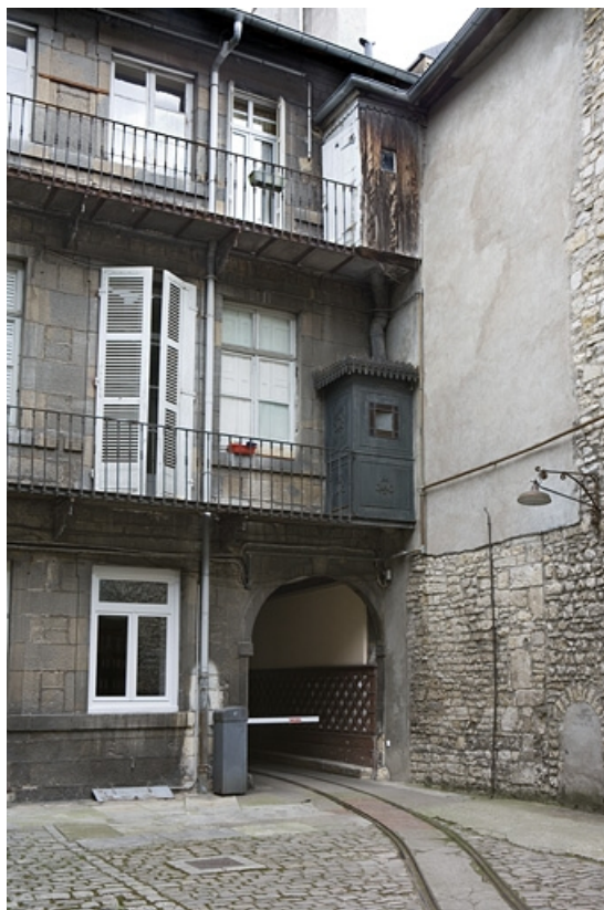
Façade postérieure du logis sur rue : détail des anciennes latrines au-dessus du portail d'entrée.
