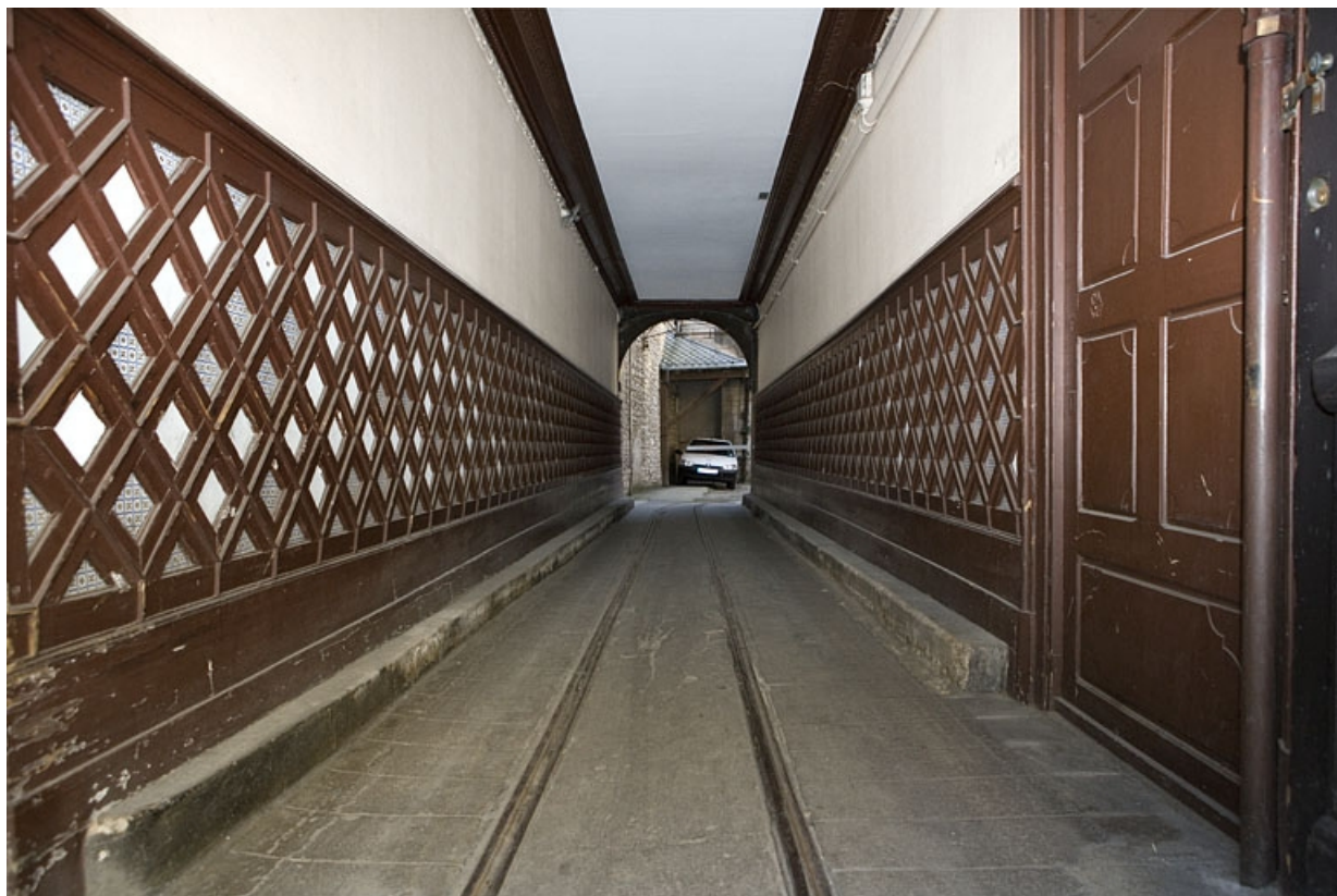
Vue d'ensemble du passage cocher depuis la rue avec la voie Decauville.
