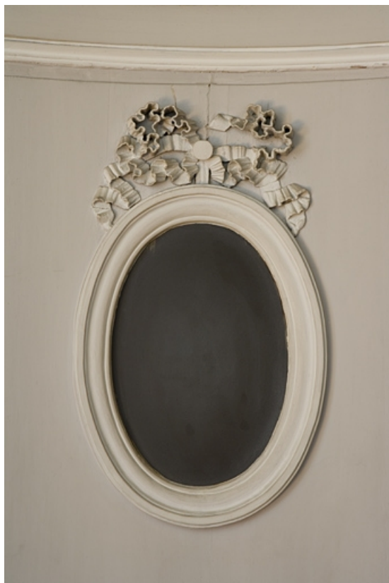
Hôtel en fond de cour, antichambre : détail de l'ouverture ovale dans la porte du couloir, à gauche de l'entrée du grand salon. 25, Besançon Grande Rue 104, lieudit : îlot Granvelle
