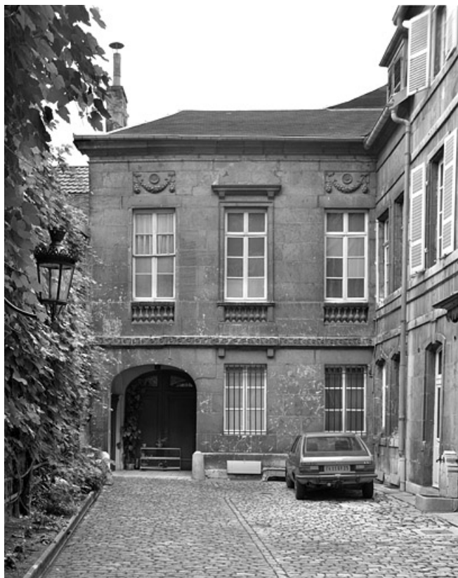
Détail de la façade de l'hôtel en fond de cour.
