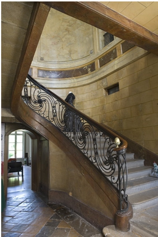
Hôtel en fond de cour, escalier : détail de la première volée avec la rampe en ferronnerie. 25, Besançon Grande Rue 104, lieudit : îlot Granvelle
