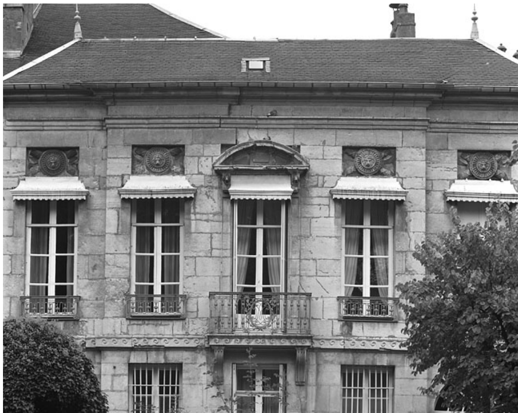
Détail du premier étage de la façade sur jardin de l'hôtel.
