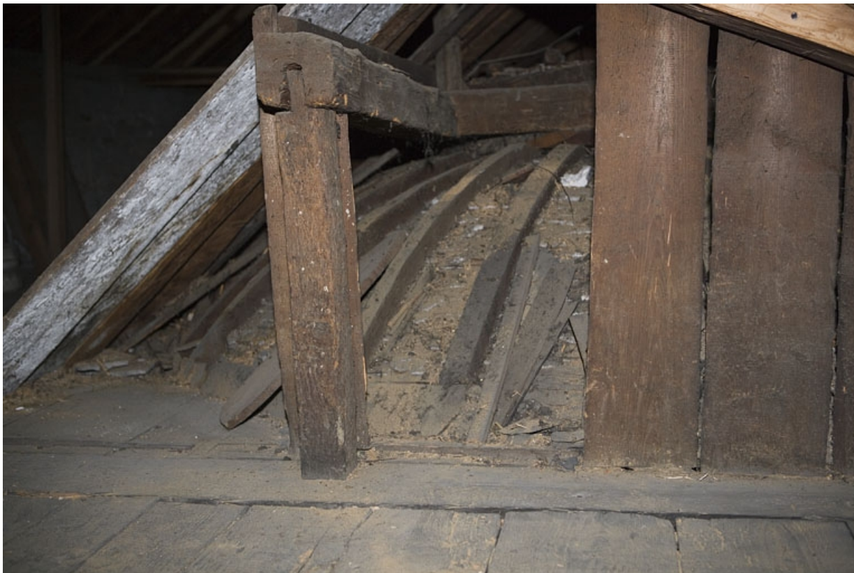
Hôtel en fond de cour : extérieur de la fausse-coupole de l'escalier situé dans le grenier.
