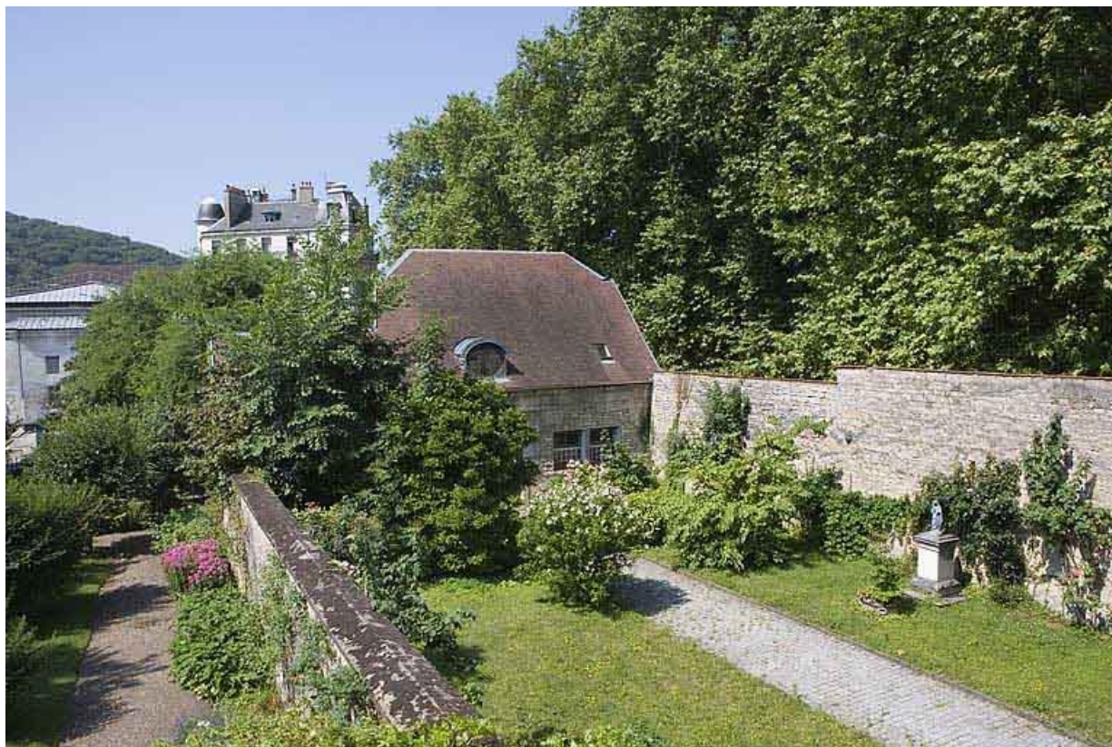
Bâtiment des remise et écurie depuis la propriété voisine.
