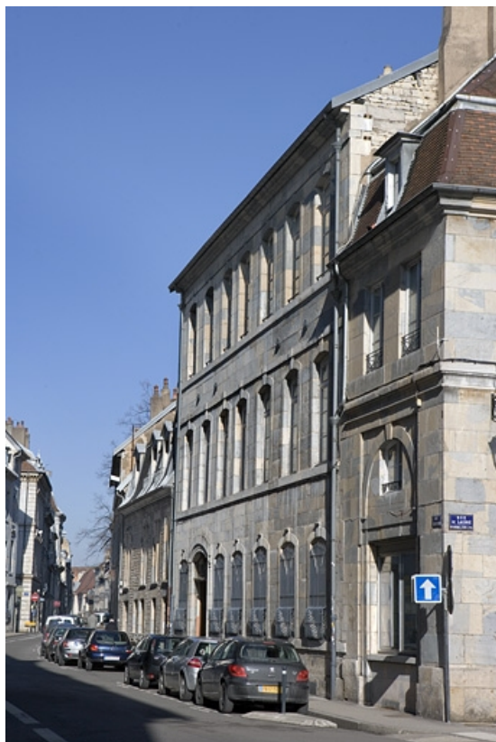
Vue d'ensemble de la façade antérieure dans l'alignement de la rue.
