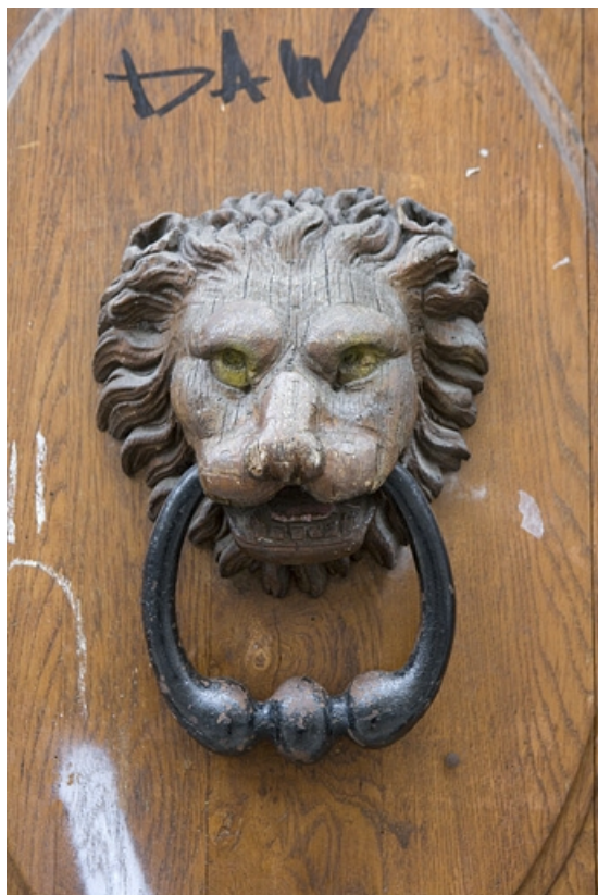
Vantail droit du portail d'entrée : détail du mufle de lion situé sur le panneau central, de face. 25, Besançon, 47 rue Mégevand, lieudit : îlot Granvelle
