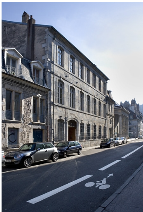
Vue d'ensemble rapprochée de la façade antérieure. 25, Besançon, 47 rue Mégevand, lieudit : îlot Granvelle
