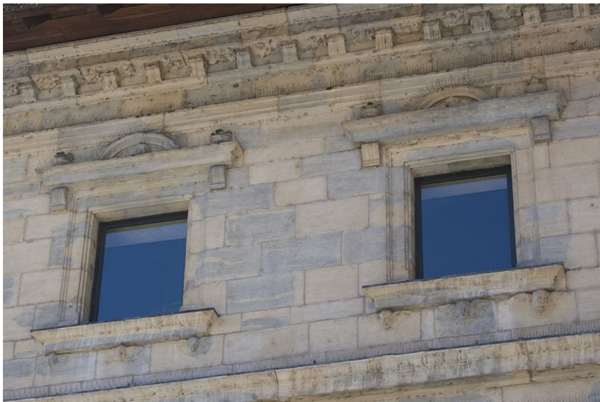
Façade principale : détail de deux fenêtres du deuxième étage.
