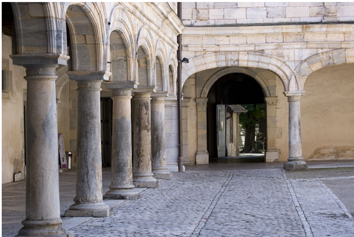
Vue du portail donnant sur l'ancien jardin depuis l'entrée de la cour.
