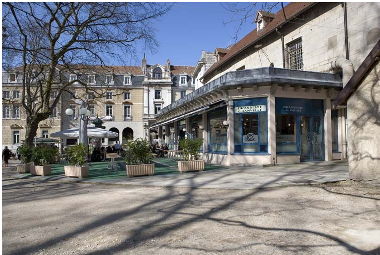
Vue d'ensemble de la brasserie contre la façade postérieure, de trois quarts droit.
