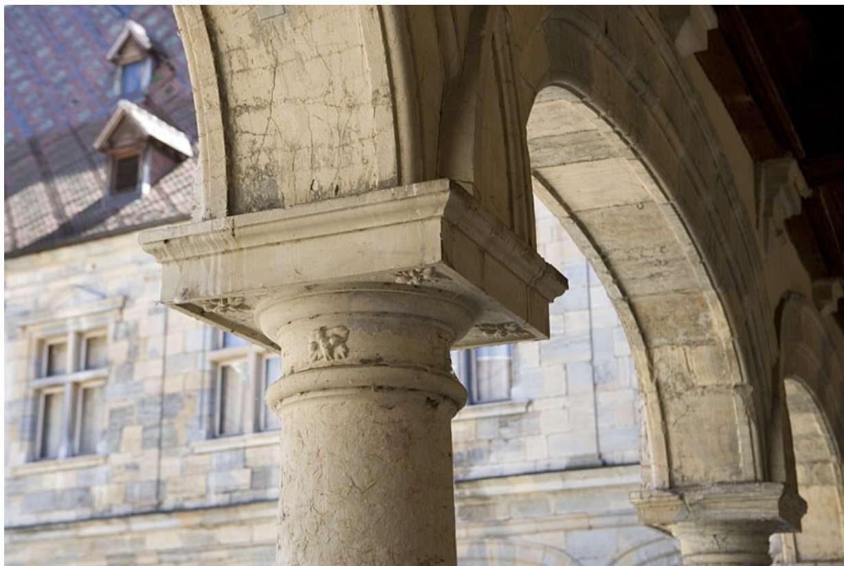
Portique : détail d'un chapiteau et de son tailloir.
