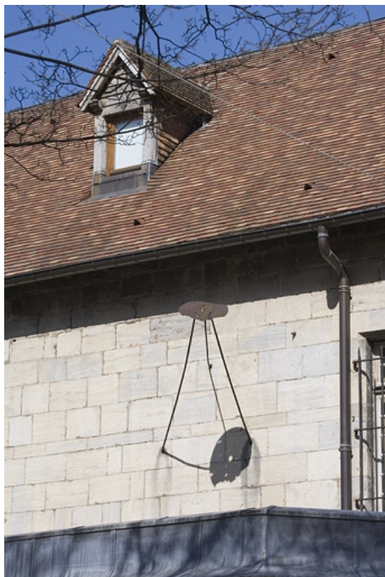
Façade postérieure : détail d'un cadran solaire en métal.
