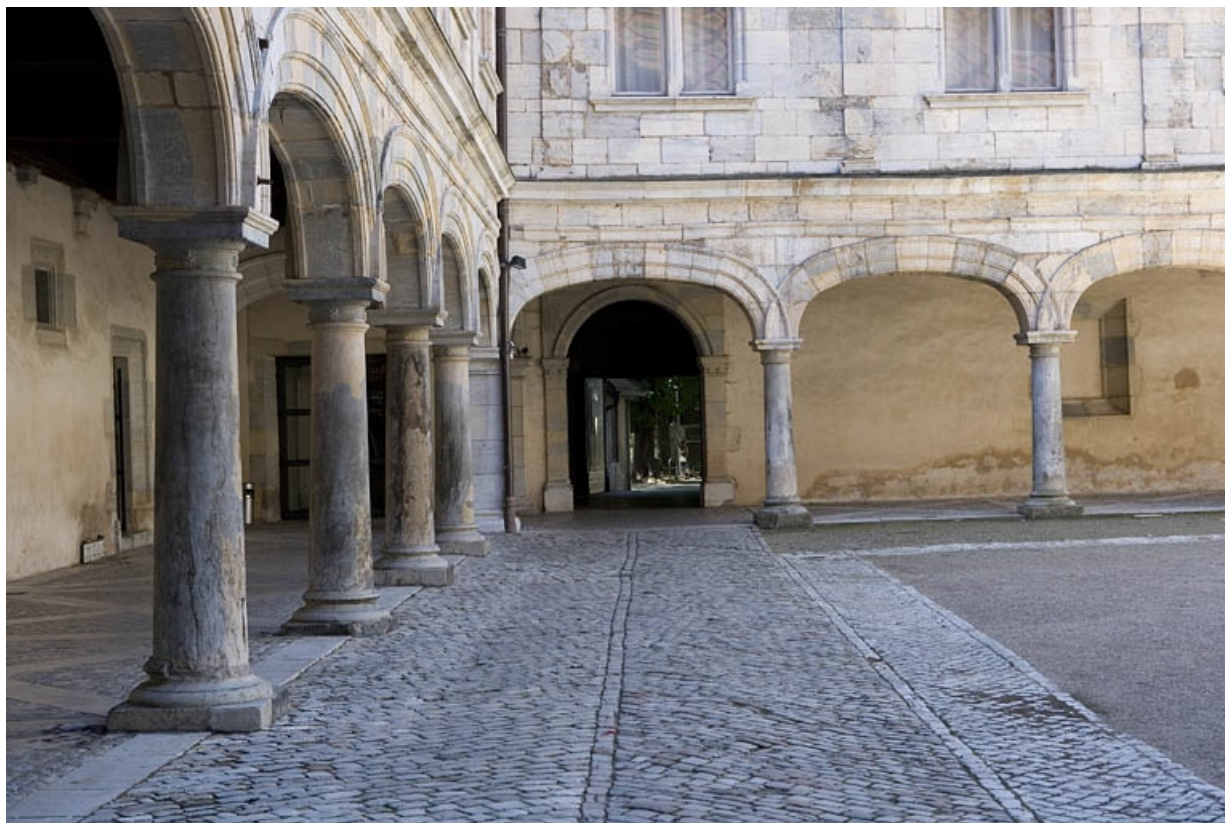
Vue du portique et du portail donnant sur l'ancien jardin depuis l'entrée de la cour.
