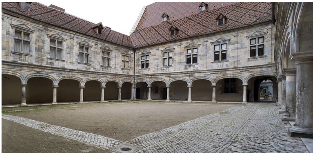
Vue d'ensemble des bâtiments sur cour depuis le sud.
