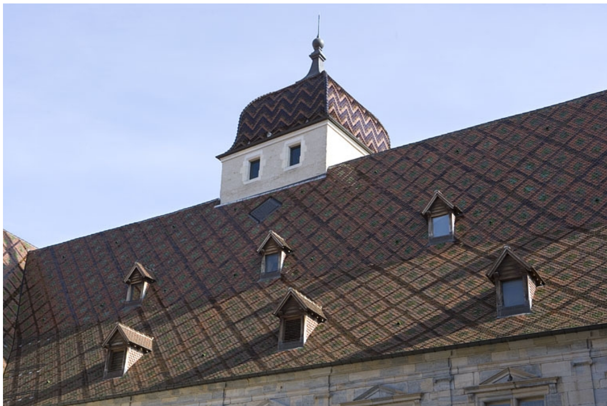
Toit de l'aile gauche avec celui de l'escalier.
