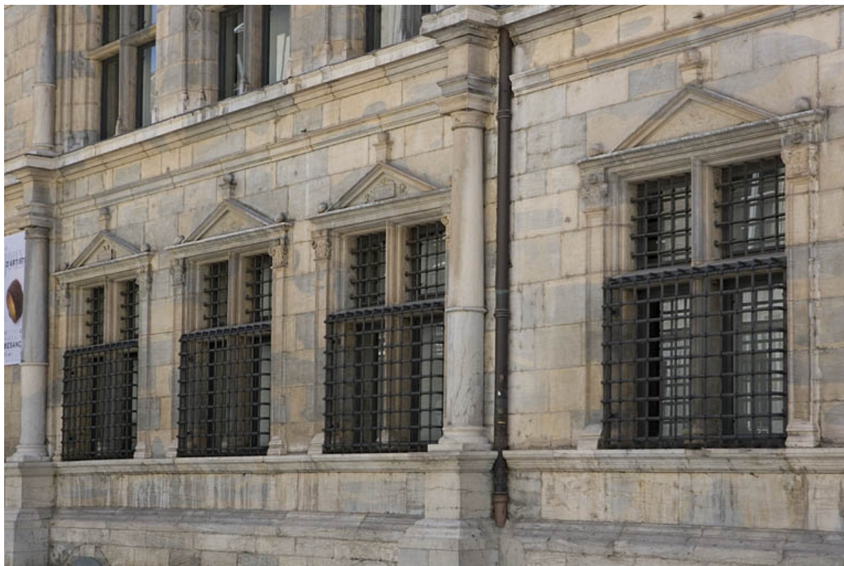
Façade principale : détail d'une partie du rez-de-chaussée à droite du portail d'entrée.
