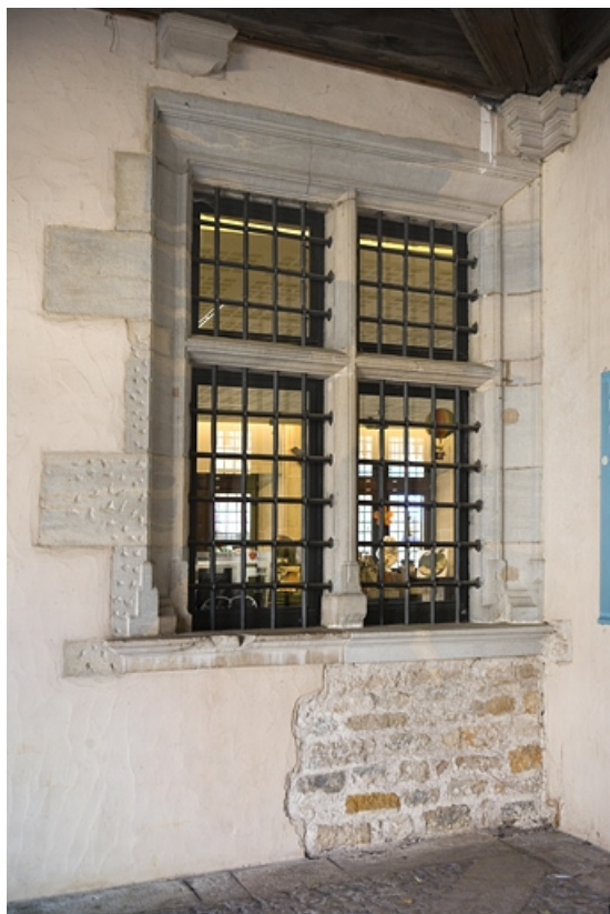
Détail d'une fenêtre à l'angle est du portique.
