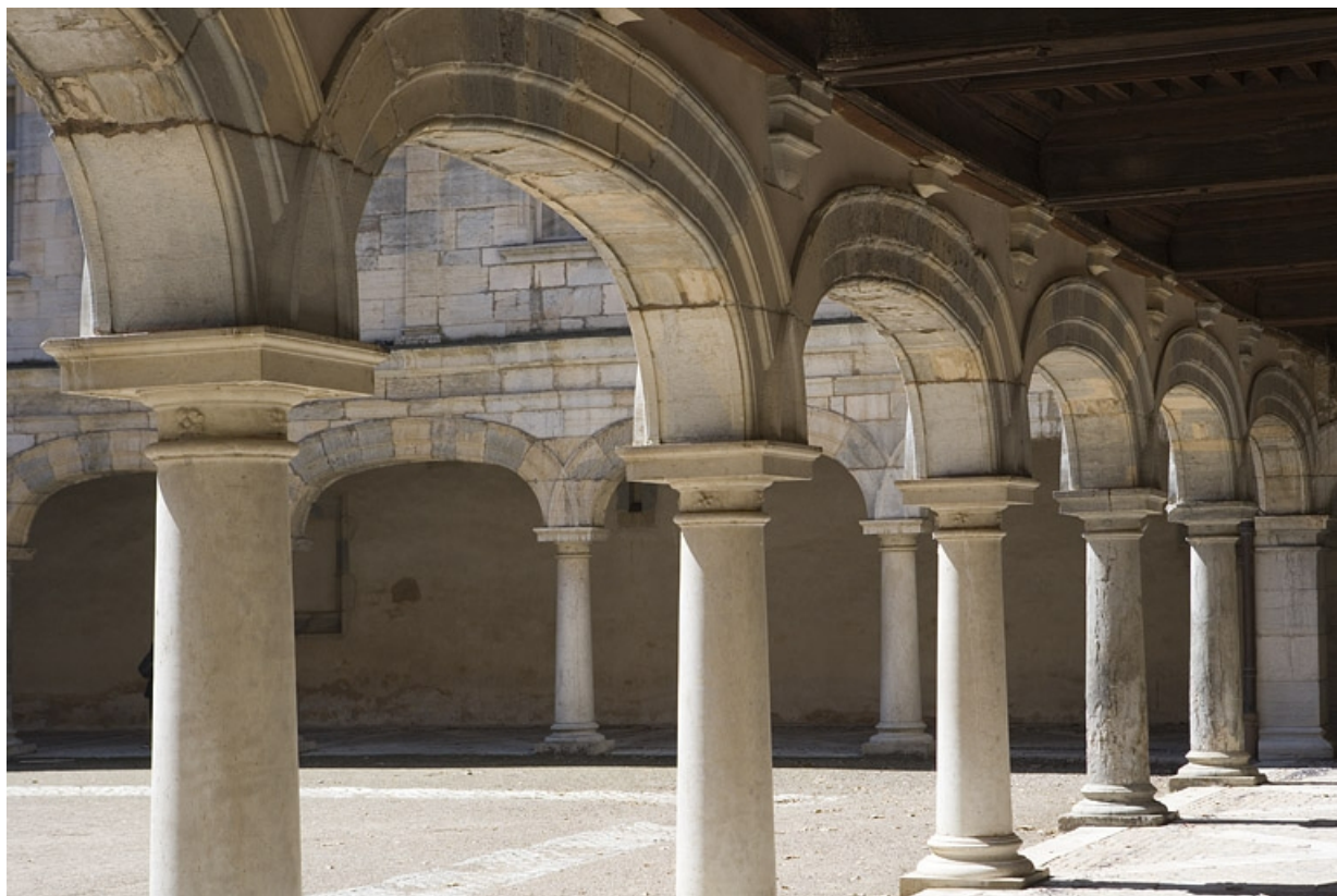
Vue de l'arcature du portique depuis le sud.
