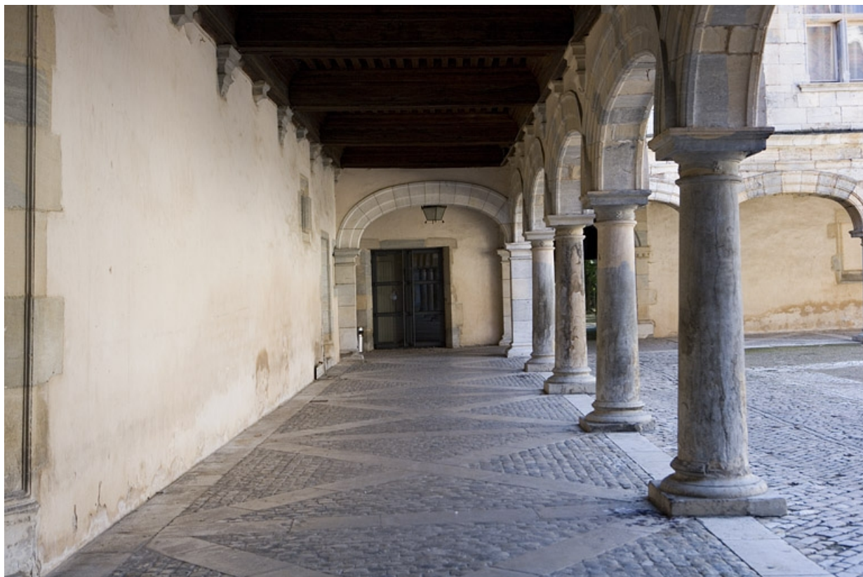
Vue du portique depuis le portail d'entrée.
