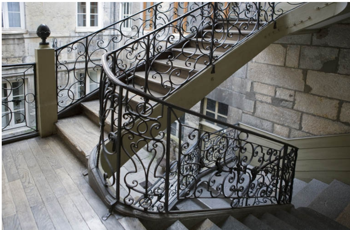
Détail de la rampe en fer forgé de l'escalier à cage ouverte. 25, Besançon, 1 rue de la Vieille Monnaie, lieudit : îlot Ronchaux
