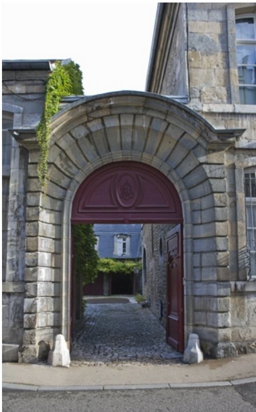
Détail du portail d'entrée et de la cour, de face.
