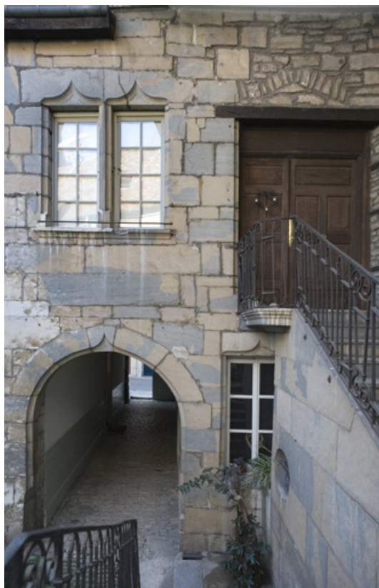
Détail du passage cocher côté cour depuis l'escalier.
