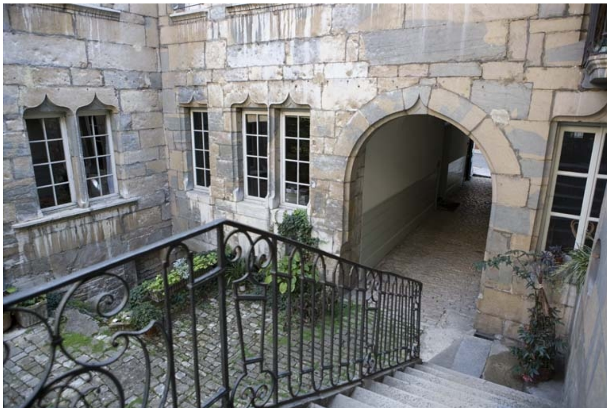
Détail du rez-de-chaussée sur cour depuis l'escalier.
