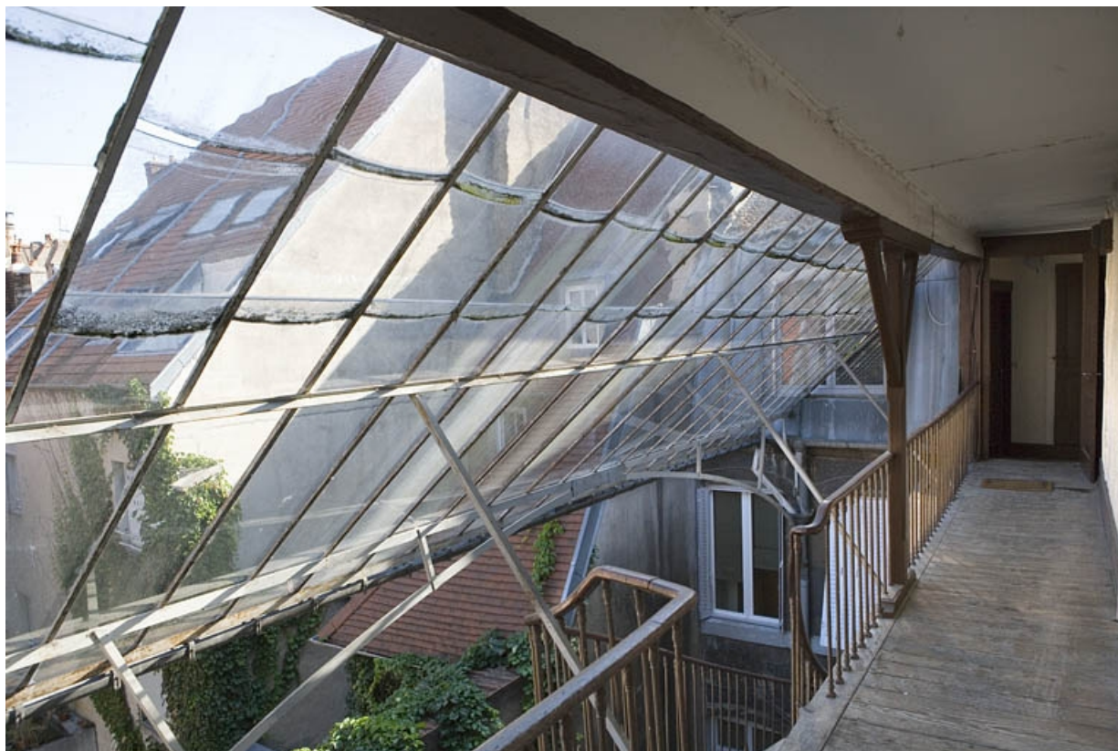
Détail de la verrière sur l'escalier à cage ouverte de la première cour.
