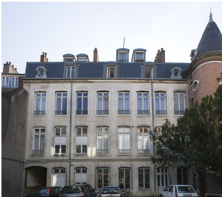
Vue d'ensemble de la façade postérieure du logis principal.
