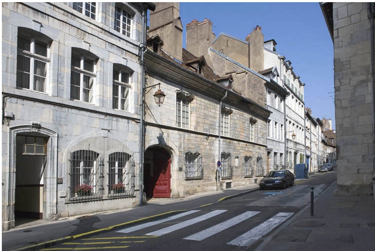
Vue d'ensemble dans l'alignement de la rue, de trois quarts gauche.
