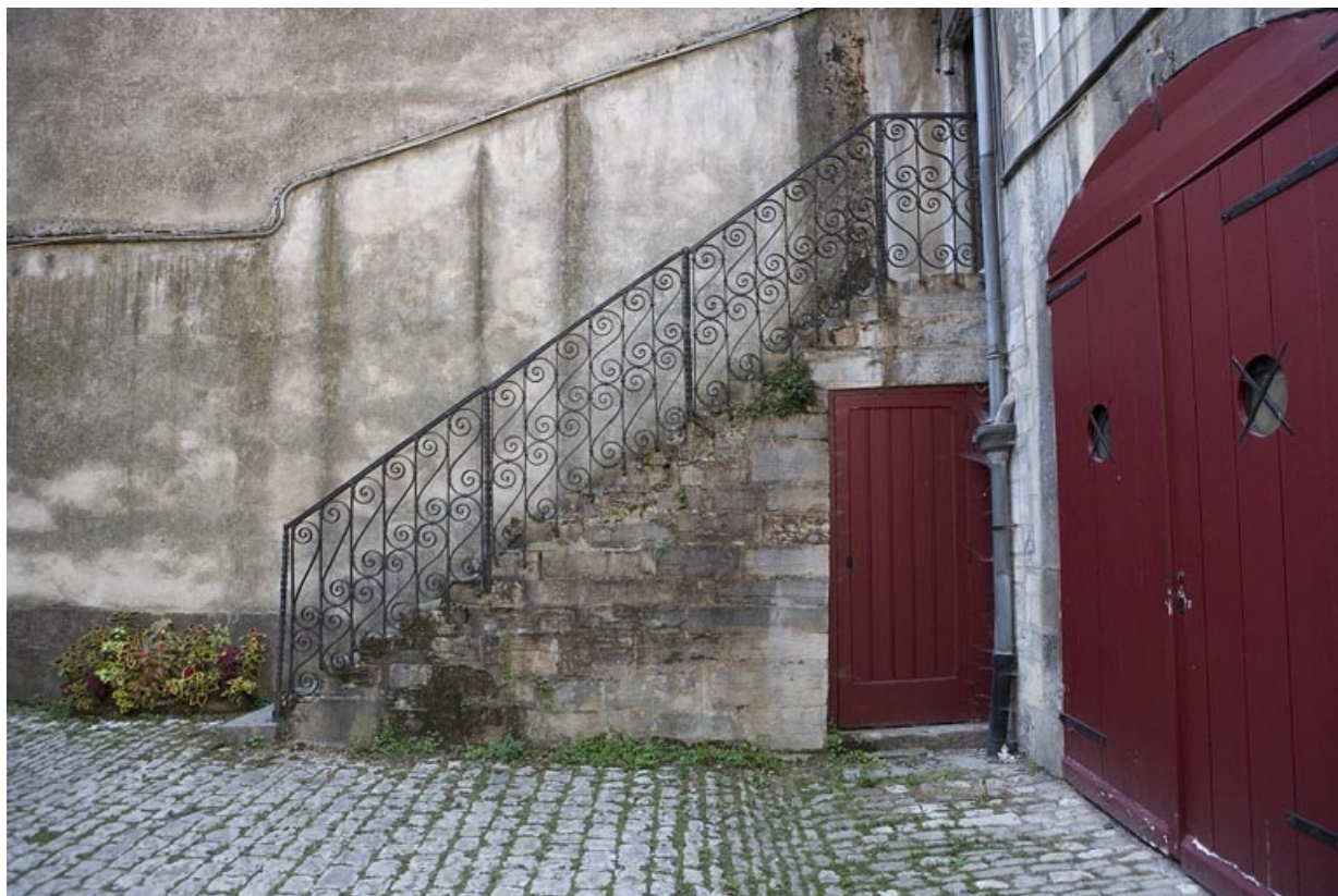
Vue d'ensemble de l'escalier extérieur du logis secondaire.
