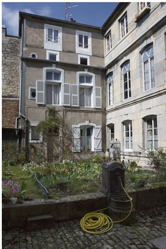
Vue partielle de la façade postérieure du logis secondaire sur jardin, de trois quarts droit.
