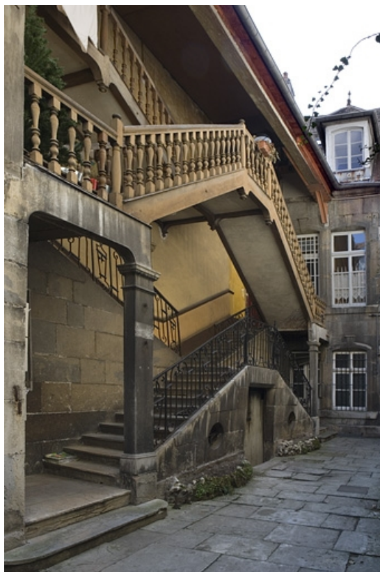
Vue d'ensemble de l'escalier à cage ouverte sur cour, de trois quarts gauche. 25, Besançon Grande Rue 136, lieudit : îlot Ronchaux
