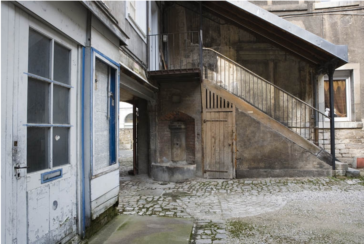
Détail de l'escalier extérieur à l'extrémité de l'aile.
