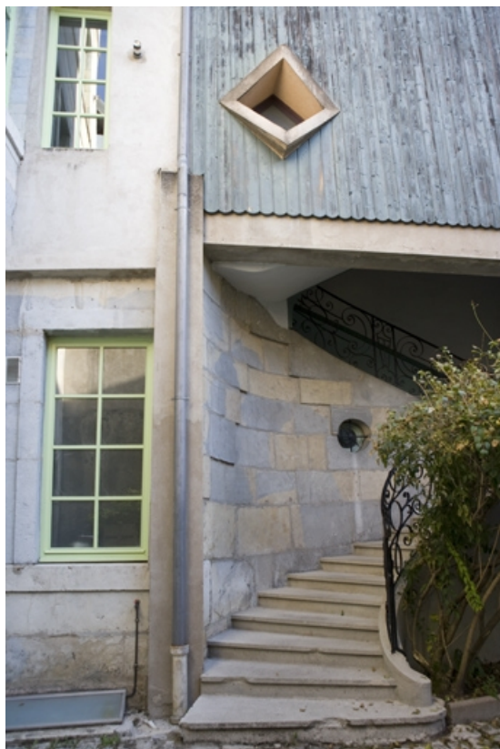
Détail du départ de l'escalier à cage ouverte sur cour, vue verticale.
