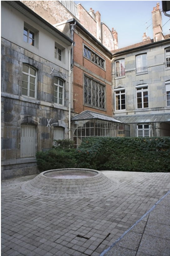
Vue d'ensemble des façades sur cour du logis principal, de trois quarts droit. 25, Besançon, 15 rue Ronchaux, lieudit : îlot Ronchaux
