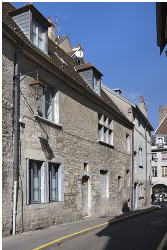
Façade latérale gauche, vue partielle.
