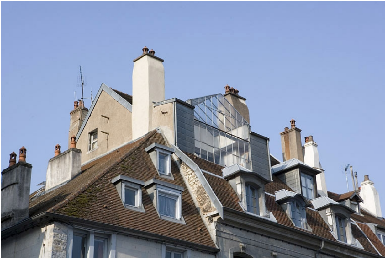
Toiture : détail de la verrière de l'atelier d'artiste, de trois quarts gauche.
