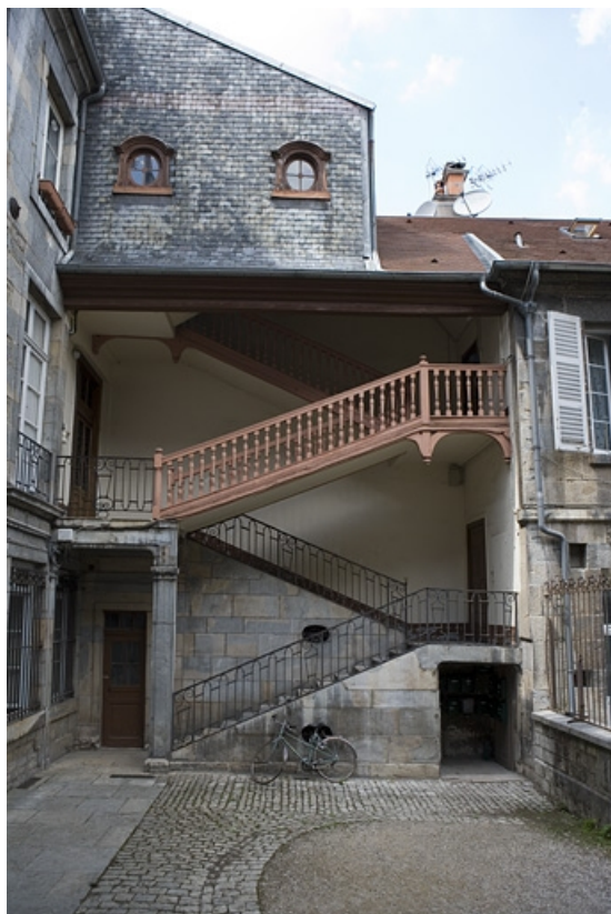
Vue de l'escalier à cage ouverte à gauche de la cour.
