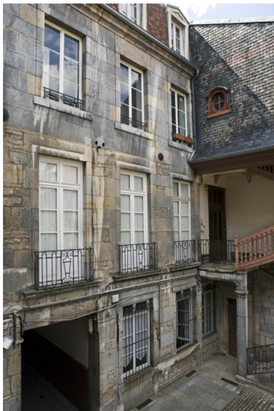
Vue de la façade postérieure du logis principal de trois quarts gauche.
