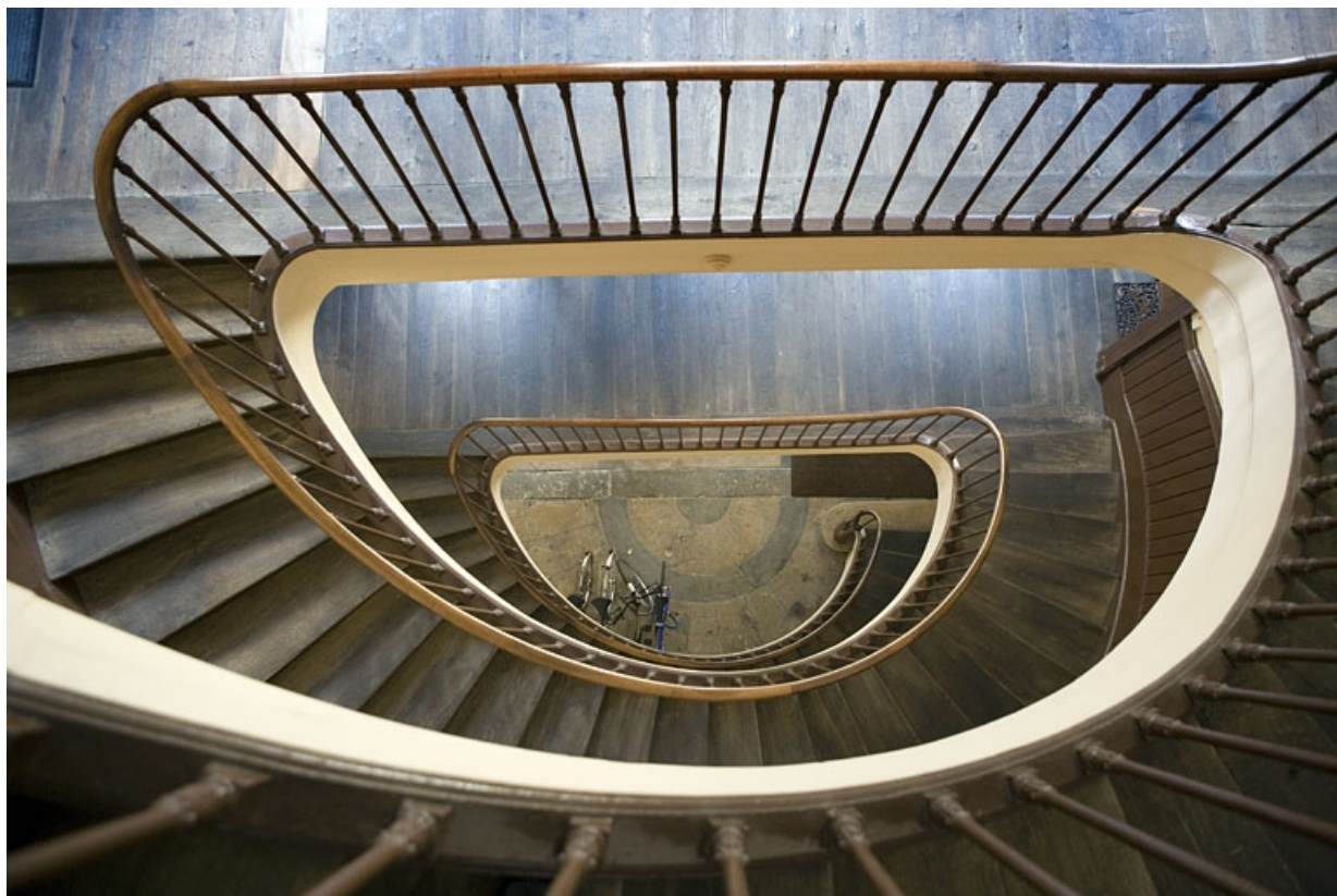
Vue de l'escalier principal en plongée depuis le dernier palier.
