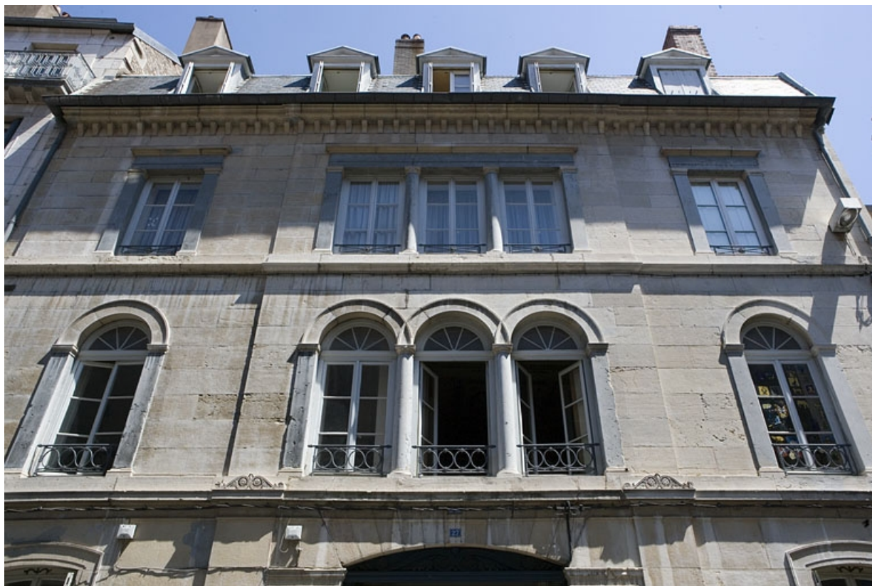
Vue d'ensemble de la façade sur rue depuis le premier étage.
