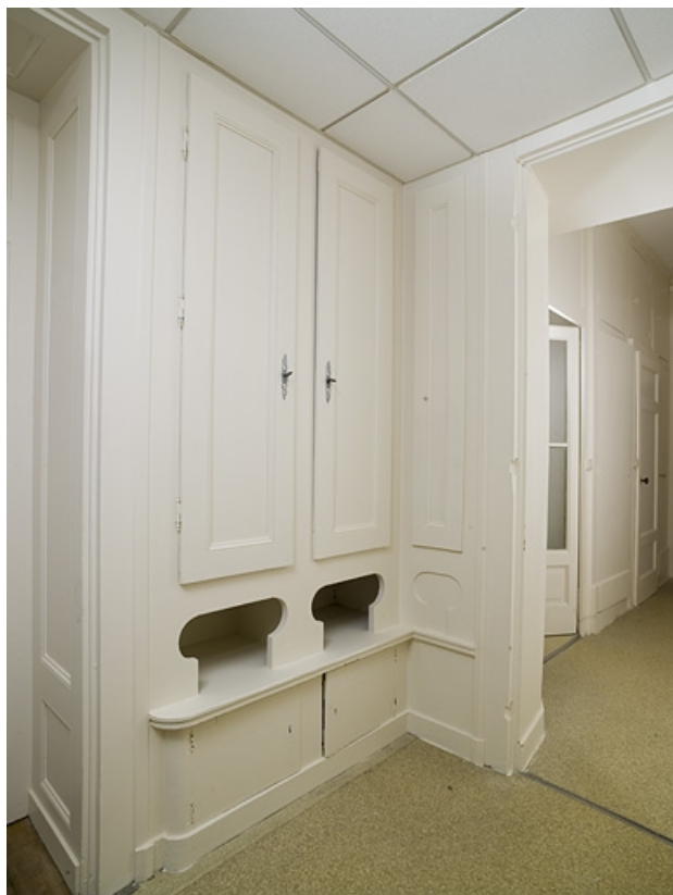
Logis principal, intérieur, couloir : détail des placards, de trois quarts gauche. 25, Besançon, 27 rue Mégevand, lieudit : îlot Terrier de Santans
