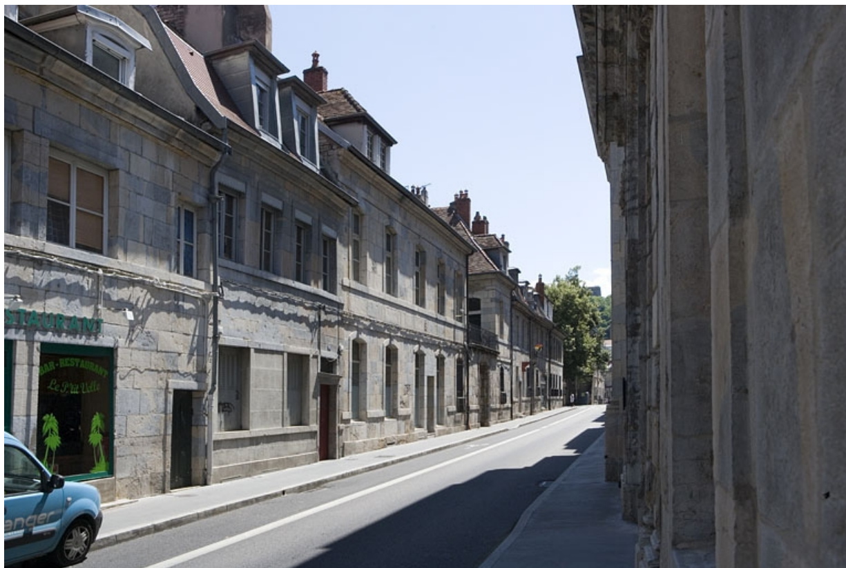
Vue d'ensemble de l'édifice dans l'alignement de la rue, de trois quarts gauche.
