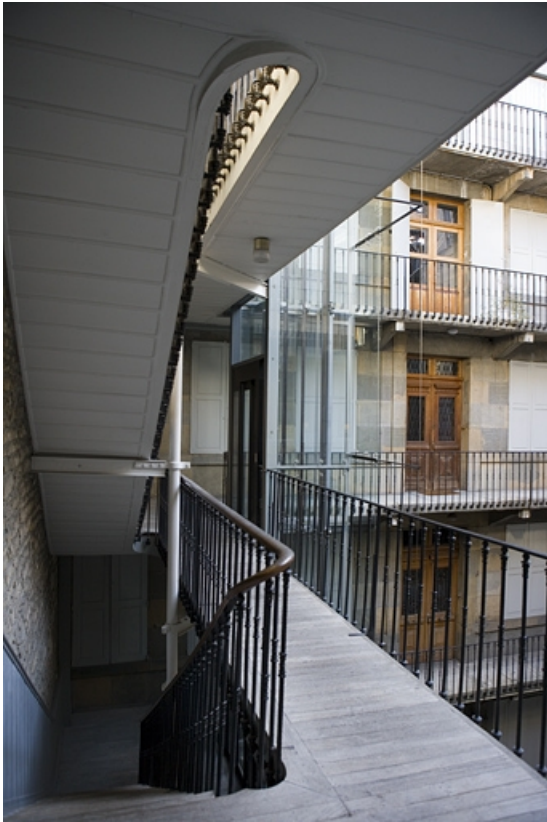
Détail de l'escalier à cage ouverte depuis l'un des paliers. 25, Besançon Grande Rue 70, lieudit : îlot Terrier de Santans
