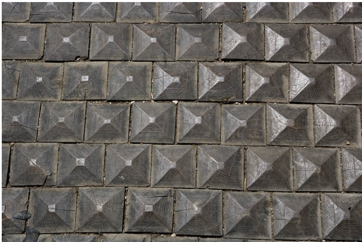
Logis principal : détail des pavés en bois du passage cocher.
