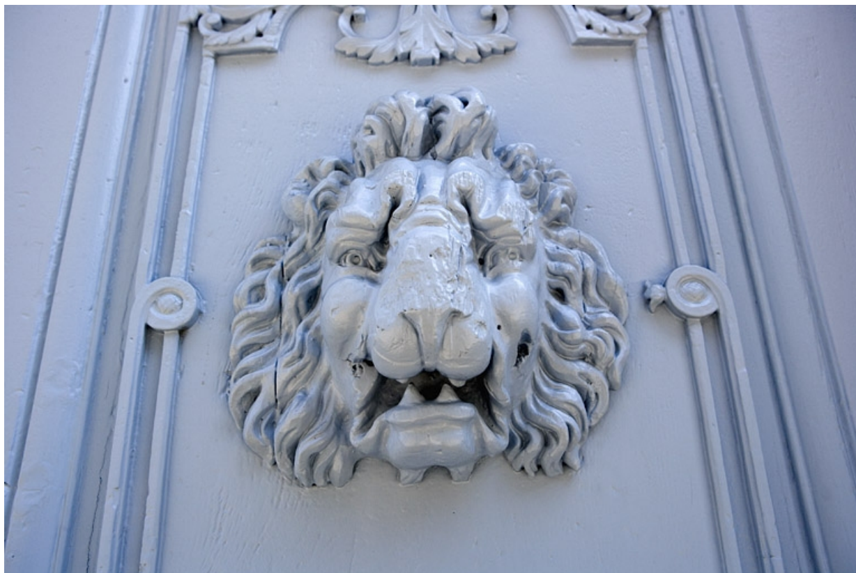
Logis principal : détail d'une tête de lion décorant un des vantaux du portail d'entrée. 25, Besançon, 17 rue Mégevand, lieudit : îlot Terrier de Santans
