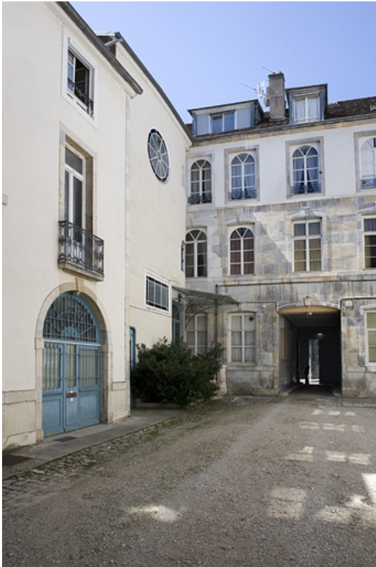
Vue de la façade postérieure du logis principal et de l'aile à droite de la cour. 25, Besançon, 17 rue Mégevand, lieudit : îlot Terrier de Santans
