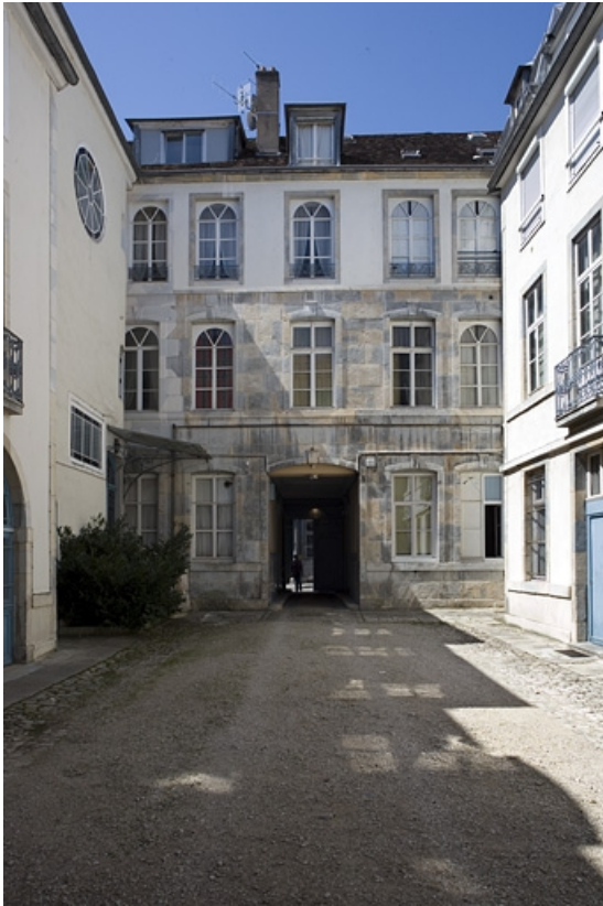
Vue d'ensemble des bâtiments autour de la première cour. 25, Besançon, 17 rue Mégevand, lieudit : îlot Terrier de Santans
