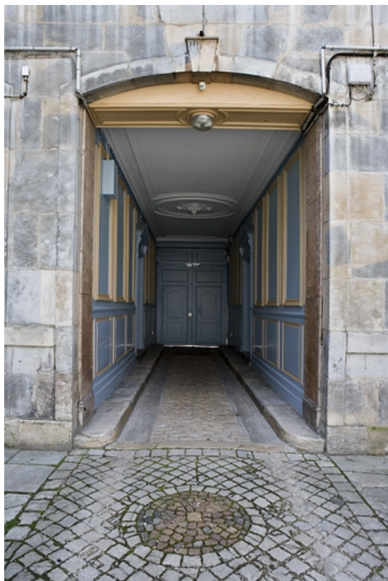
Logis principal : vue d'ensemble du passage cocher depuis la cour. 25, Besançon, 17 rue Mégevand, lieudit : îlot Terrier de Santans
