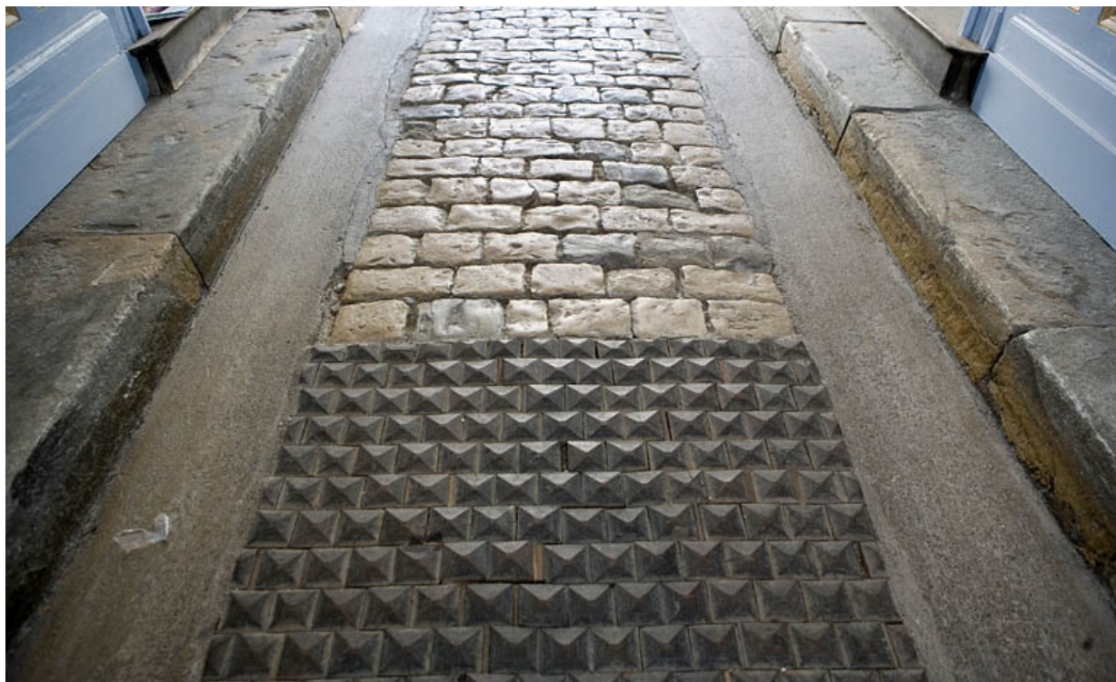
Logis principal : détail des pavés en bois et en pierre du passage cocher.
